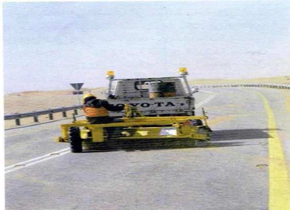
صورة معدة دهان الطرق ( لأعمال الصيانة )
