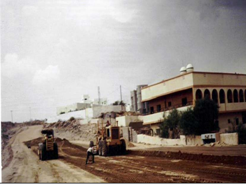
تنفيذ طريق داخلي بإحدى الأحياء السكنية
