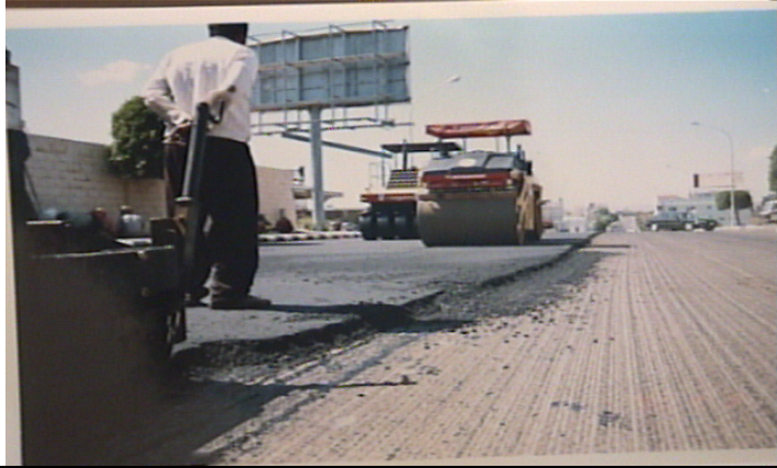
دمك الخليط بالمداحل الحديدية ثم الكفريات
