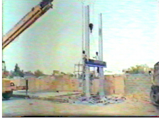
تثبيت أعمدة الإشارات
