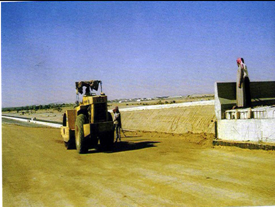
دمك الطبقة بالرصاصه الحديد
