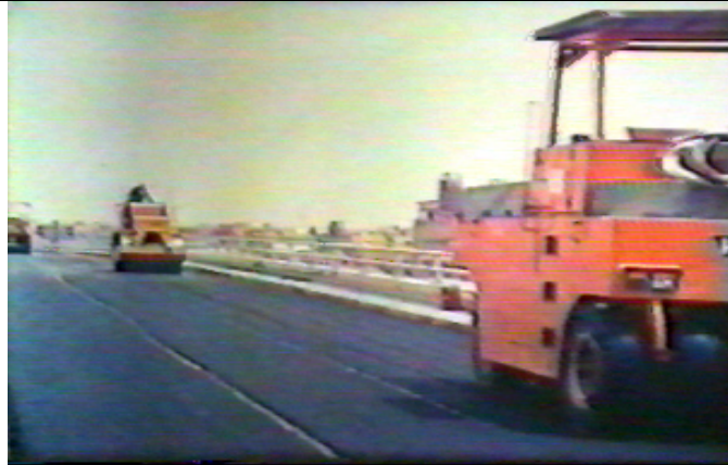
الدمك النهائي بالهراس الحديدي
