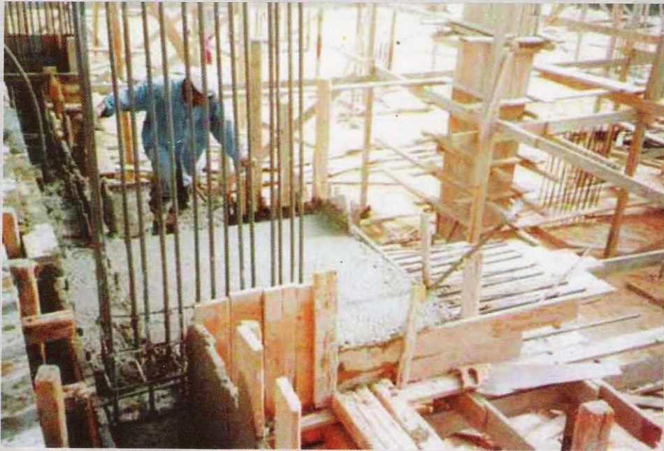
• تركيب إضافات شبكة حديد التسليح العلوى بركوب وامتداد 4/1 طول البحر المجاور
