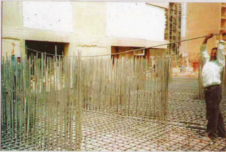
• تركيب إضافات شبكة حديد التسليح العلوى بركوب وامتداد 4/1 طول البحر المجاور
