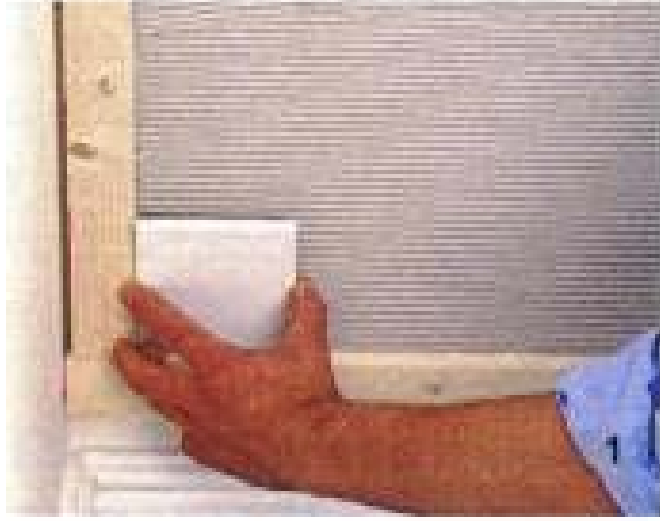
(شكل رقم ٤٣- طريقة اللصق الرقيق بمادة لاصقة تفرش على الحائط)
