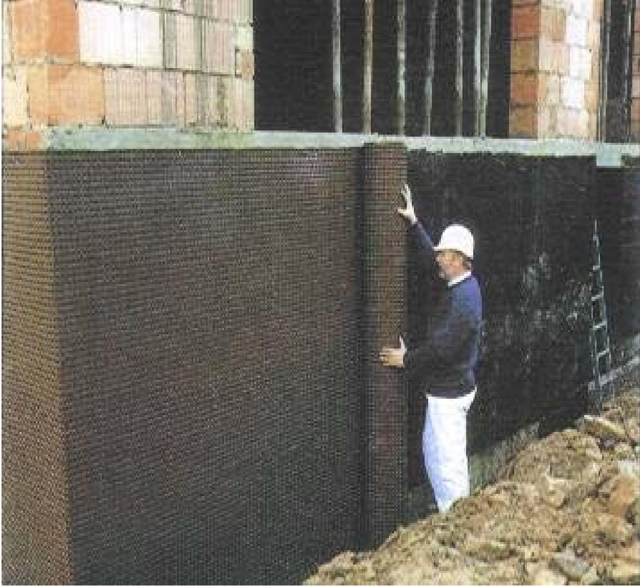
(شكل رقم ٧٤- سائل عازل للمياه مدهون على الحائط مع حمايته بلفائف لمادة عازلة )
