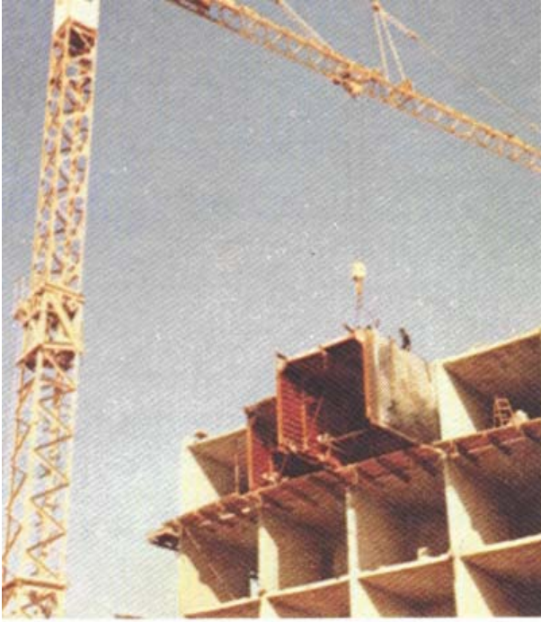
الصور توضح شكل الشدات المنزلقة وطريقة وضعها لصب الحوائط والأسقف لإقامة المباني في أحد مناطق القاهرة
