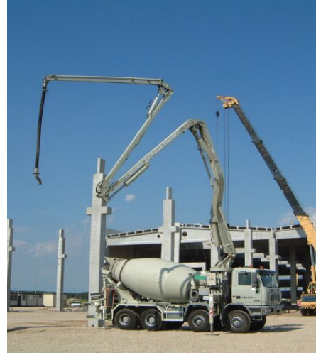
الشكل 17 : مضخة للخرسانة
