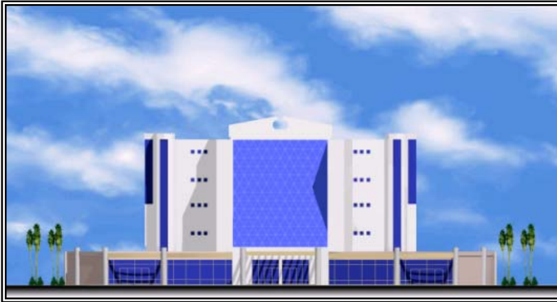
الواجهة الشمالية الشرقية لمبنى إداري
