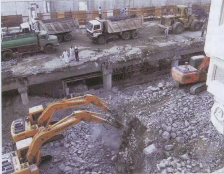
أعمال الهدم لتهيئة بناء التوسعة
