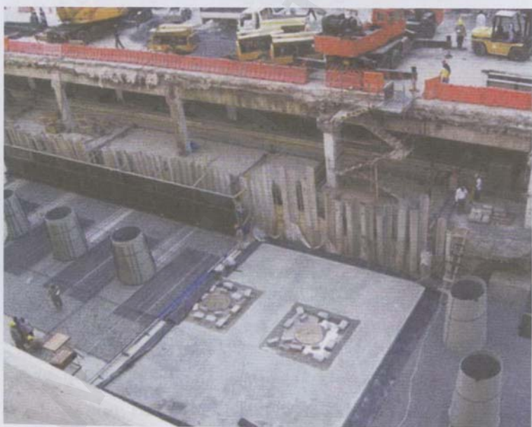
من أعمال الإنشاء
