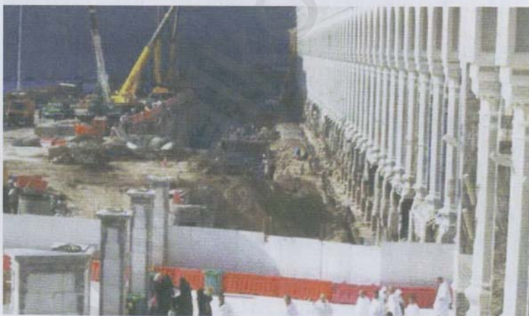
أعمال التحضير والهدم
