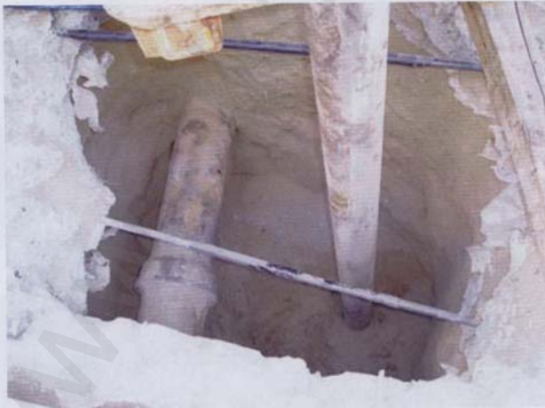
عملية الحفر لمنطقة جبل المروة
