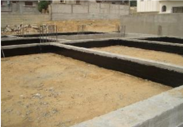
شكل يوضح طرق تنفيذ العزل للعناصر الخرسانية
