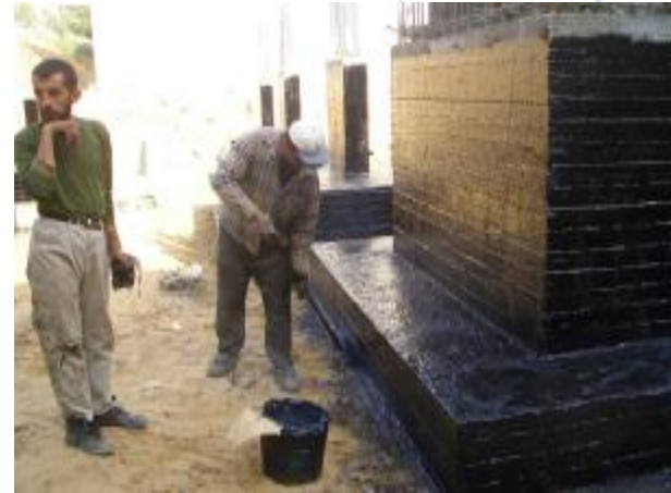
شكل يوضح طرق تنفيذ العزل للعناصر الخرسانية
