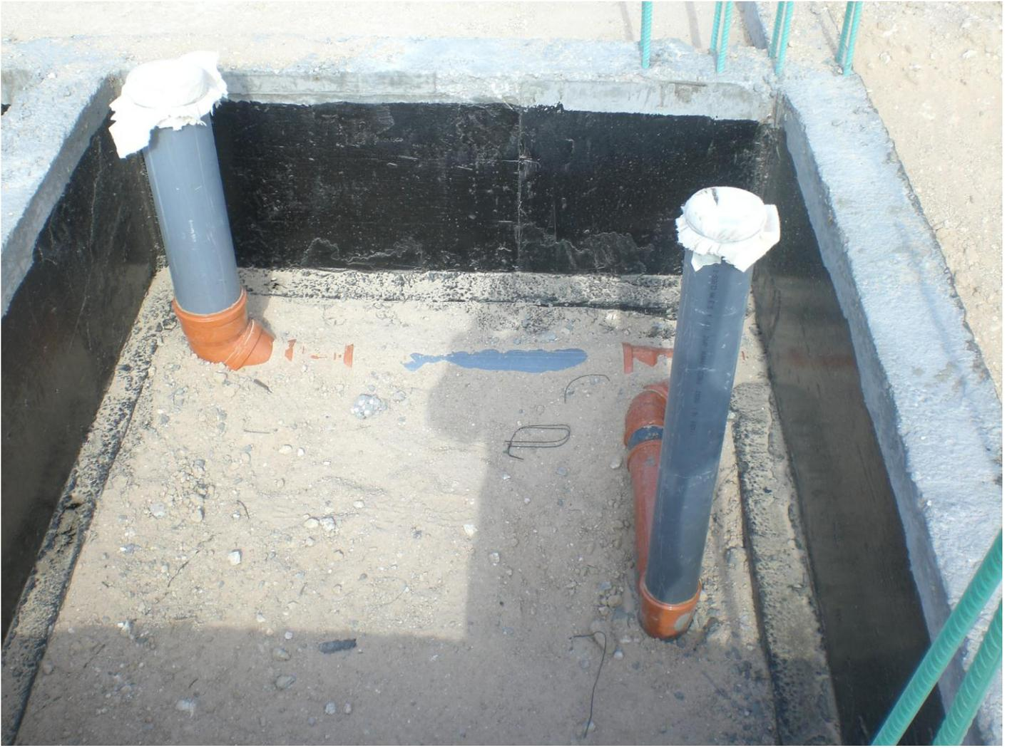
ثم بعد ذلك يتم اختبار التوصيلات الصحية اما بالهواء واما بالماء ويجب التدقيق فى استلام التوصيلات وصحتها تفاديا للأخطاء الشائعة بعد الانتهاء من المشروع ومع اول استعمال تظهر عيوب التوصيلات بسبب عدم التدقيق فيها ، ثم بعد ذلك نقوم بعملية الدفان والتجهيز للأرضية
