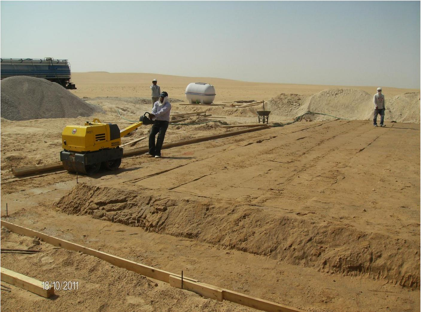
ثم بعد الرص والدك جيدا يأتي دور اختبار التربة وبعد التأكد من نجاحها يأتي دور القواعد العادية وقبل البدء في القواعد العادية لابد من التأكد من حدود المبنى باستخدام جهاز التيديوليت وذلك لضمان نجاح المشروع بدون اخطاء:
