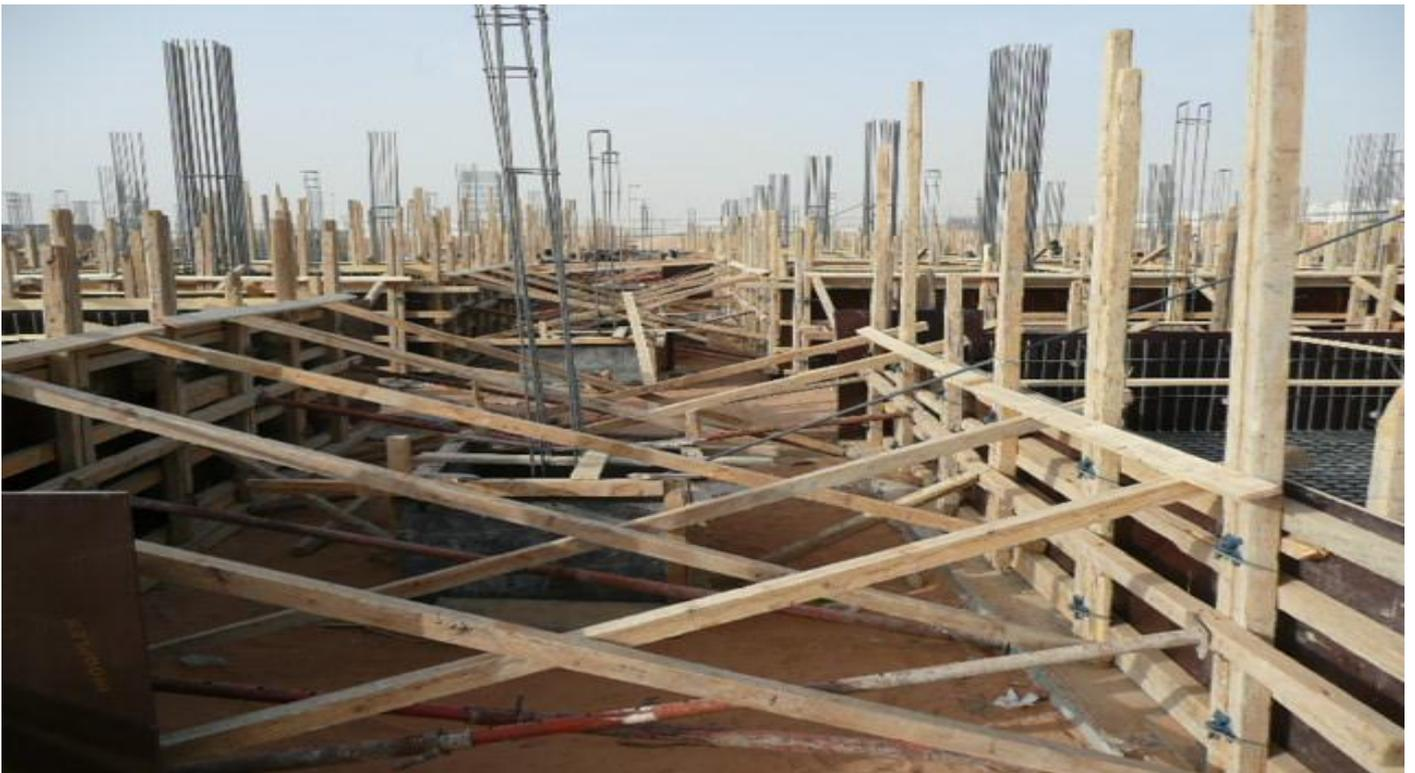
ثم يتم تجهيز قوالب لمكعبات الخرسانة وتجهيز القواعد والشدة ورشها بالمياه وتنظيفها جيدا وتجهيزها للصب ثم يتم صب الخرسانة المسلحة واخذ عينات منها عدد ٦ مكعبات اثنان يتم اختبارهم بعد ٧ ايام والباقي بعد ٢٨ يوم من تاريخ الصب ويتم اخذ العينات من خرسانة صحيحة لا تكون بها نسبة مياه كبيرة وتكون خلطة متجانسه ويتم صب مكعبات الاختبار على ٣ طبقات كل طبقه يتم غزرتها جيدا بسيخ حديد قطر ١٦ مم ٢ مرة لكل طبقه ثم بعد الانتهاء من الطبقة الاخير وتسوية السطح يتم كتابة التاريخ عليها
