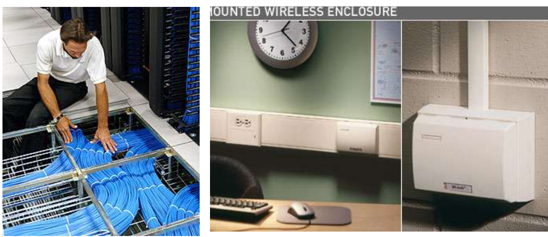
صورة 2-6 بعض أنواع الـ Raceways : فوق الحوائط (يمين) ، تحت الأرض (شمال).
