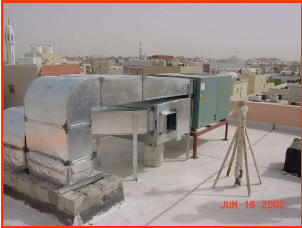
شكل 3-11 تركيب الوحدة المدمجة Package
