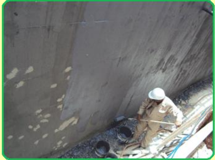
الصورة توضح طريقة العزل للحائط بالبدروم.
