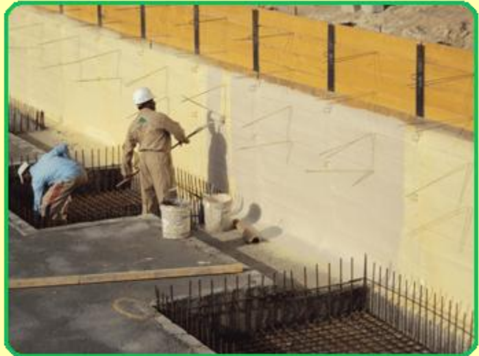
الصورة توضح مراحل عزل حائط التدعيم للبديوم بالبولي يورثين .
