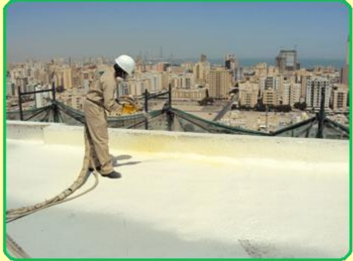
الصورة توضح طريقة عزل الدروة مع السطح .
