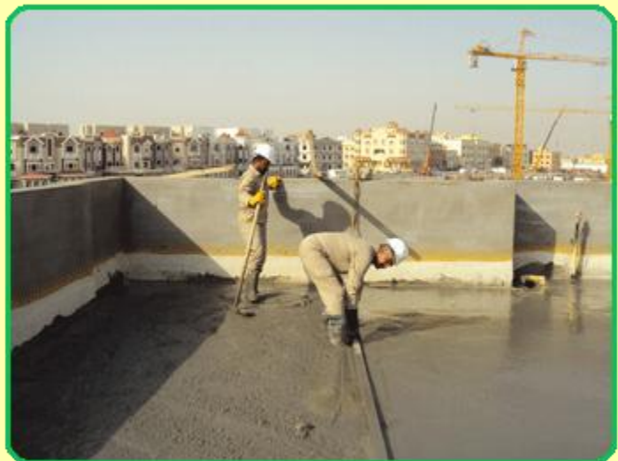
الصورة توضح صب خرسانة السطح مع استخدام فواصل.
