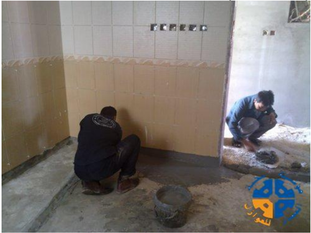
عزل المطابخ و الحمامات بالعازل الأسمنتي و المطاطي ( العزل المائي )
