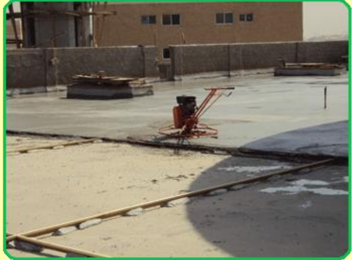
الصورة توضح الأوتار وصب خرسانة جاهزة مع استخدام المروحة .
