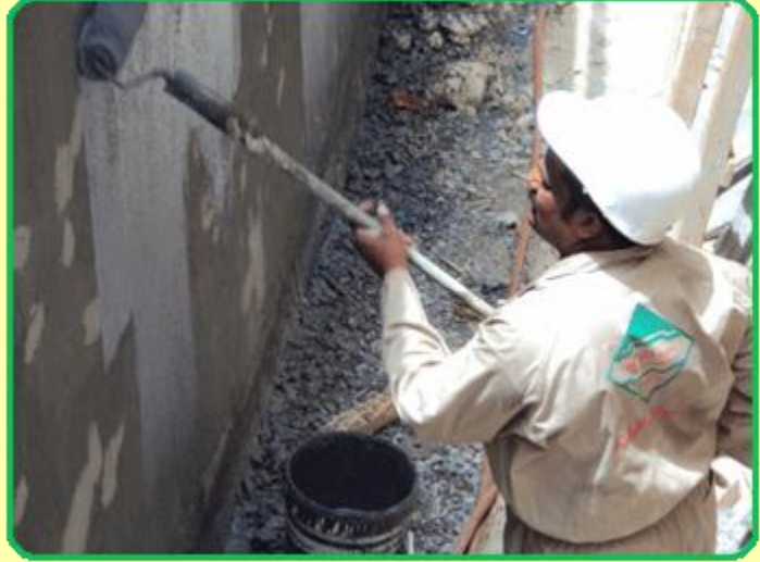
الصورة توضح حائط البدروم معزول وجه واحد عازل أسمنتي بعد معالجة النتوءات.
