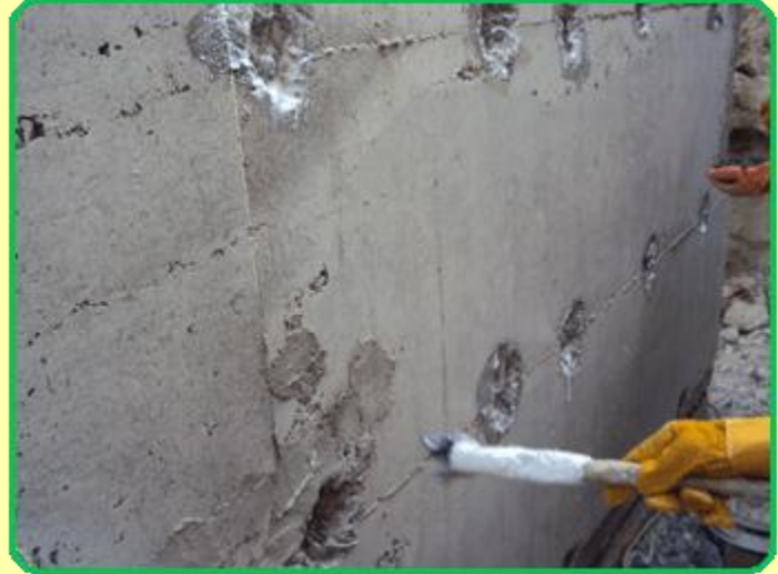
الصورة توضح مراحل معالجة الخرسانة الضعيفة بالحائط للبدروم.
