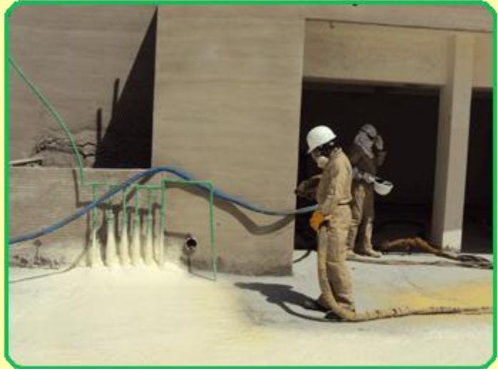
الصورة توضح طريقة عزل المواسير.
