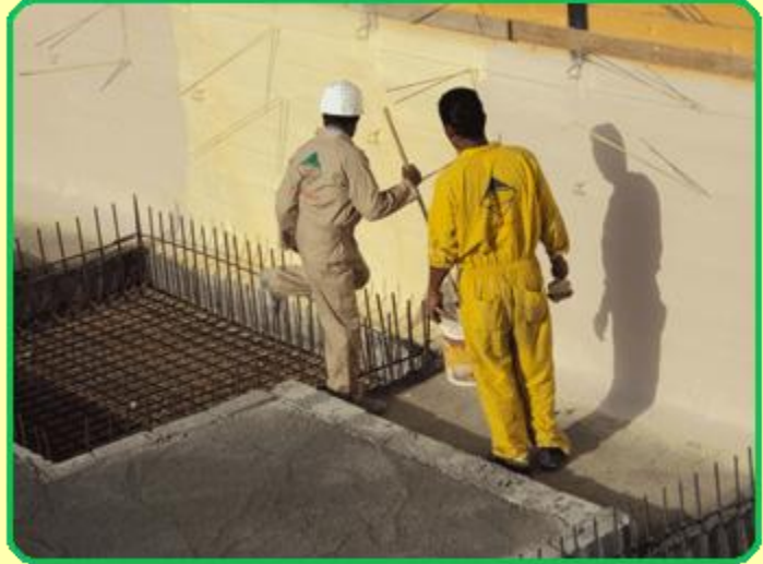
الصورة تبين مراحل عزل حوائط التدعيم بالبديوم.
