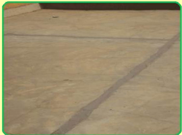
الصورة توضح فاصل تمدد بعد الانتهاء من تعبئته بالمعجون .
