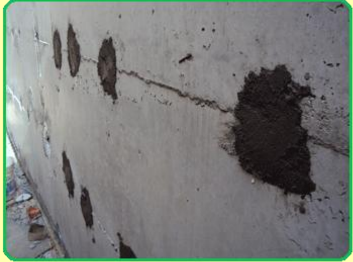
الصورة توضح مرحلة من مراحل المعالجة بحوائط البدروم.
