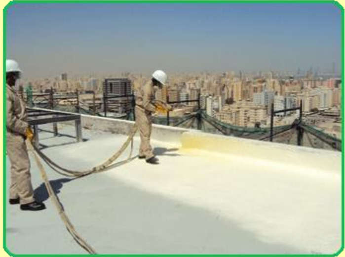
الصورة توضح عزل السطح و الدروة.
