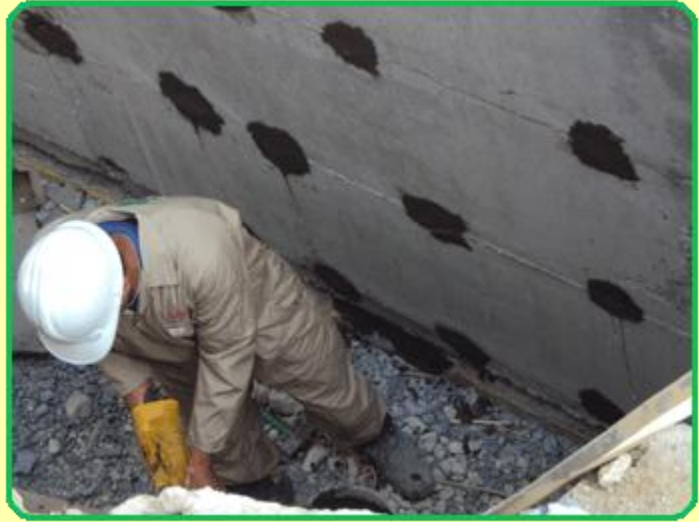
الصورة توضح جزء من الحائط للبدروم بعد معالجة النقاط الضعيفة بالخرسانة .
