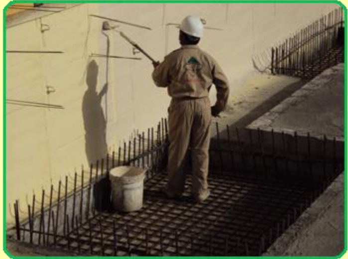
الصورة توضح عزل حوائط التدعيم بمراحلها المتخلفة .
