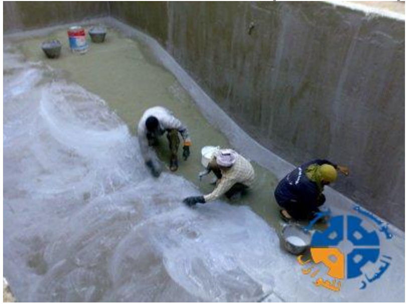
عزل حمامات السباحة بالعازل الأسمنتي ( الكيماوي ) ( العزل المائي )
