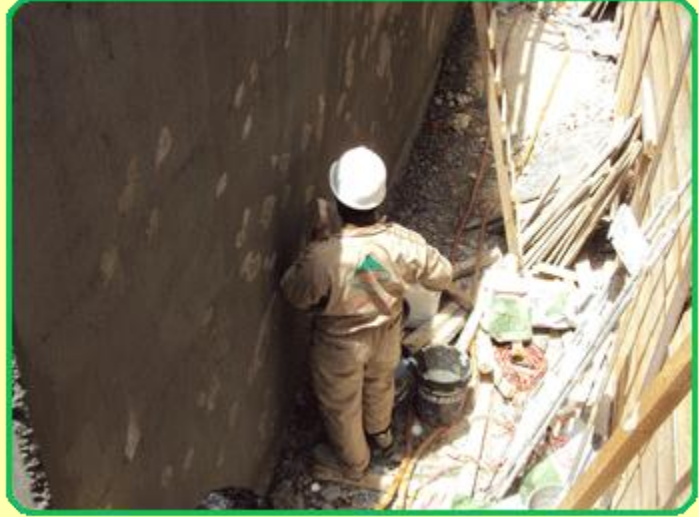
الصورة توضح عزل حائط بالبدروم من الخارج .
