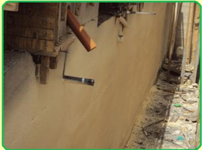
الصورة توضح عزل حائط البدروم بالبولي يورثين .
