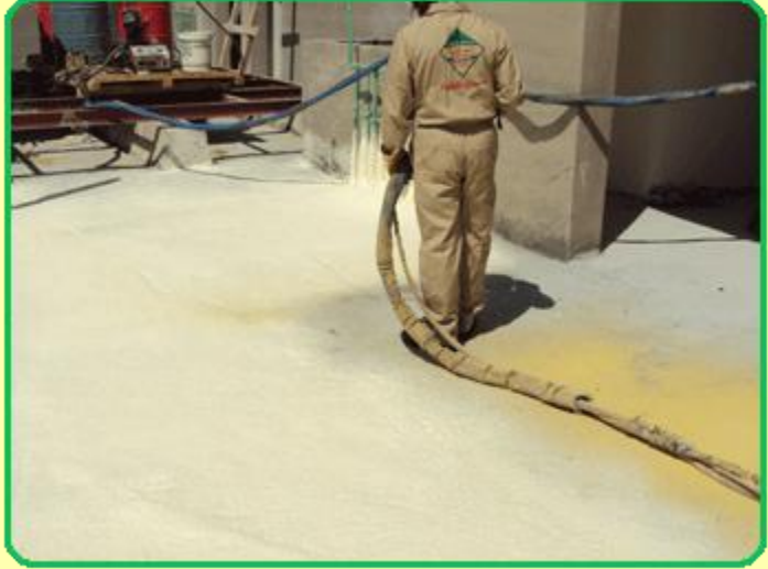
الصوره توضح عزل قطاع بالسطح وطريقة التعامل مع المواسير .
