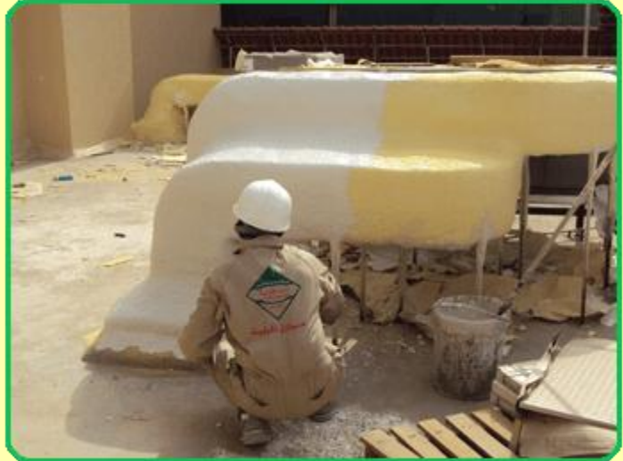
الصورة توضح طريقة تغليف دكت التكييف بالبولي يورثين العازل للماء والحراره.
