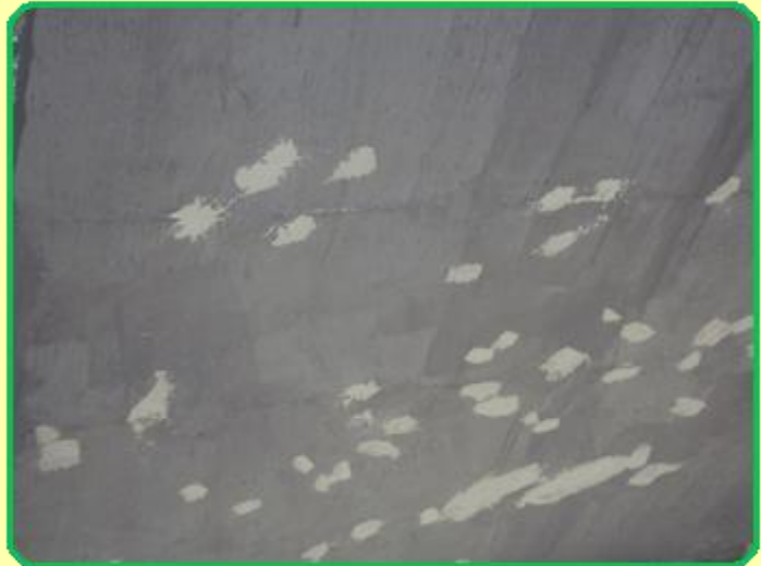
الصورة توضح حائط البدروم معزول وجه واحد عازل أسمنتي مع معالجة النتوءات .
