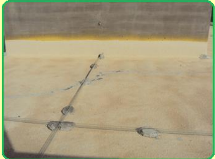
الصورة توضح الأوتار قبل صب خرسانة بالسطح .
