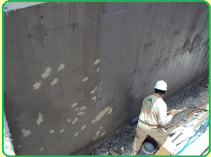
الصورة توضح طريقة العزل للحائط بالبدروم.
