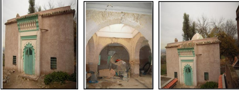
صور رقم : 04توضح الواجهة الرئيسية لضريح
