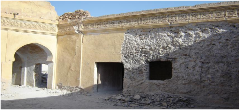
عملية التنظيف الشقوق و إزالة الطبقات المتآكلة
