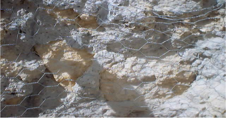
التقوية باستعمال الشبكة الحديدية والحجارة لزيادة التماسك
