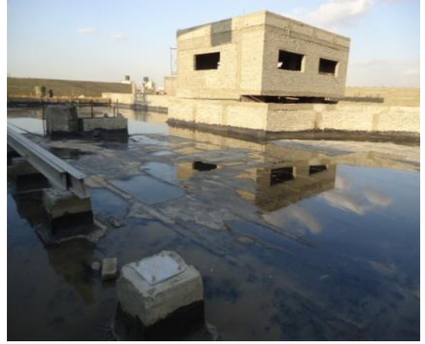
اعمال العزل المائى للمبنى الرئيسى وبعد وضعها يتم اختبارها بتغطيتها بالمياة لمدة 24 ساعة كاملة لنرى ما تاثير ذلك على السقف.
