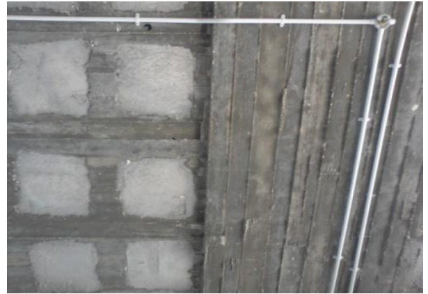
فى الاسقف الحمل من السقف للكمرة المدفونة او المخفية ثم للعمدان ثم للاساسات
