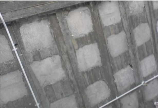
فى الاسقف الحمل من السقف للكمرة المدفونة او المخفية ثم للعمدان ثم للاساسات
