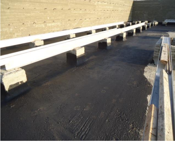
اعمال العزل المائى للمبنى الرئيسى وبعد وضعها يتم اختبارها بتغطيتها بالمياة لمدة 24 ساعة كاملة لنرى ما تاثير ذلك على السقف.
