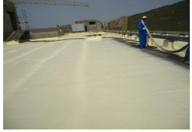
العزل الحرارى بالبتق أو الرش .
