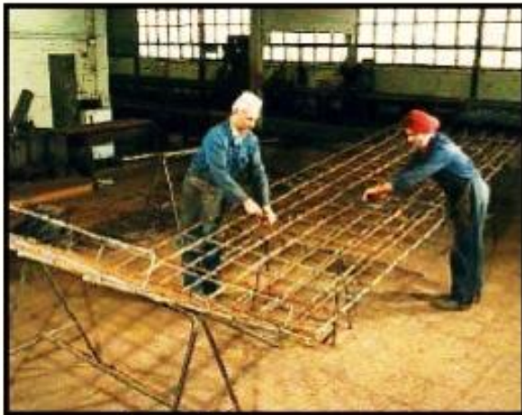
تجهيز حديد التسليح لبلاطة سابقة الصب
