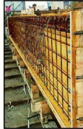
تجميع القوالب لكمرة من الخرسانة سابقة الصب
