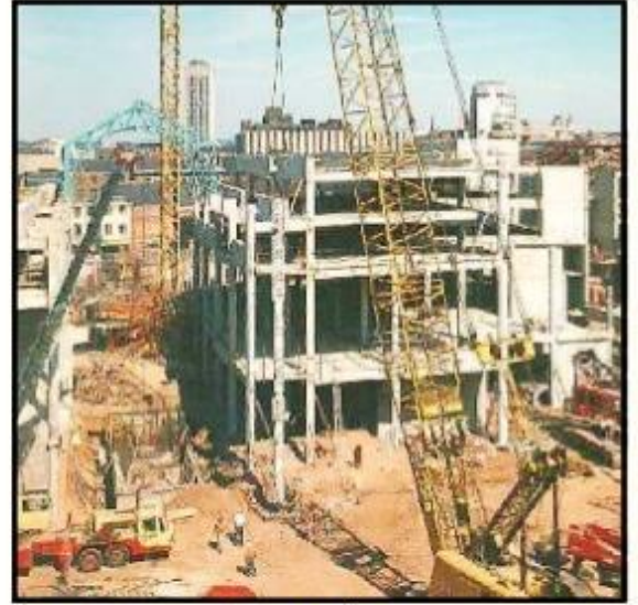
تركيب الوحدات الخرسانية الجاهزة فى مكانها مباشرة
