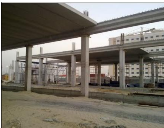
شكل (8) يوضح الوحدات المستوية المصممة
