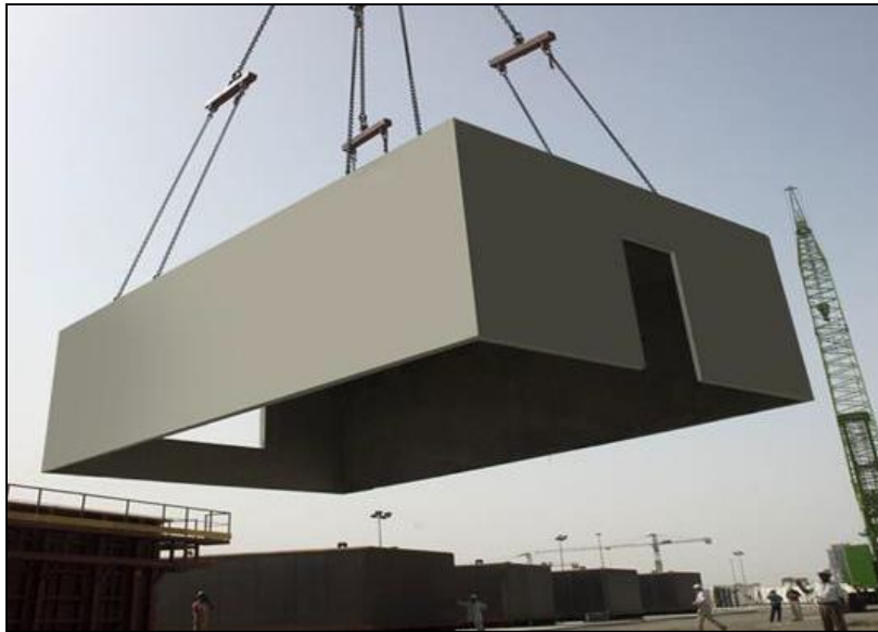
شكل (7) يوضح الوحدات كبيرة الحجم
