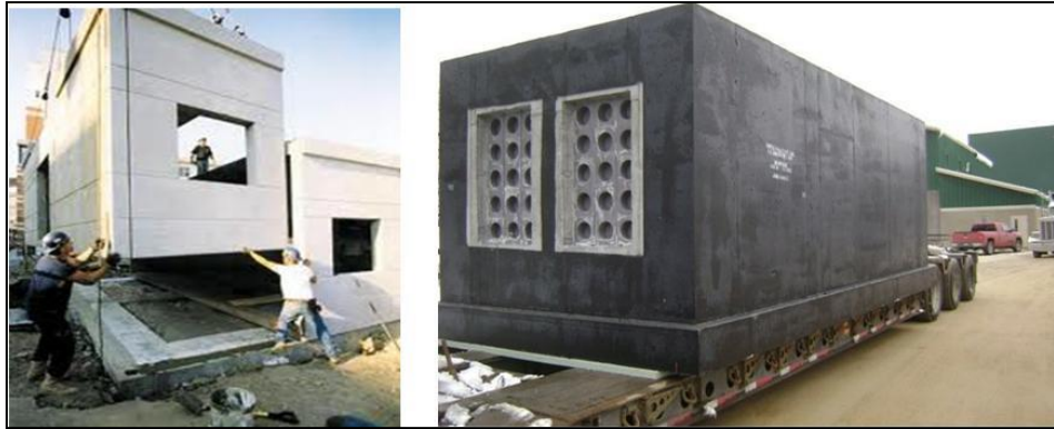
شكل (11) يوضح الوحدات الصندوقية الصغيرة
