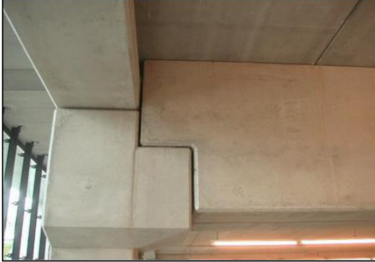
شكل (3) يوضح وحدات إنشائية أخرى لتقفيل الفراغات
