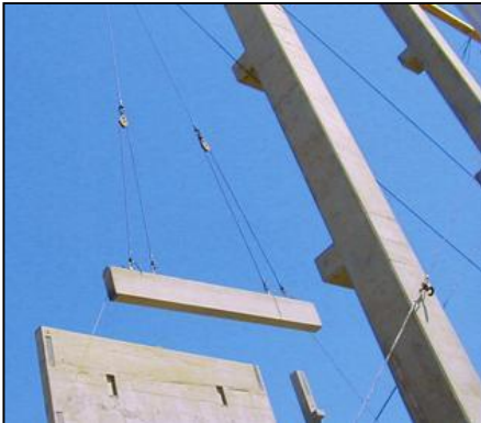
شكل(2) يوضح الأعمدة المتصلة التي تكون بأرتفاع المبنى
