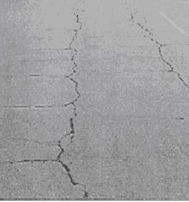
شكل رقم (٢٢) يوضح شدة متوسطة للشقوق الشبكية
