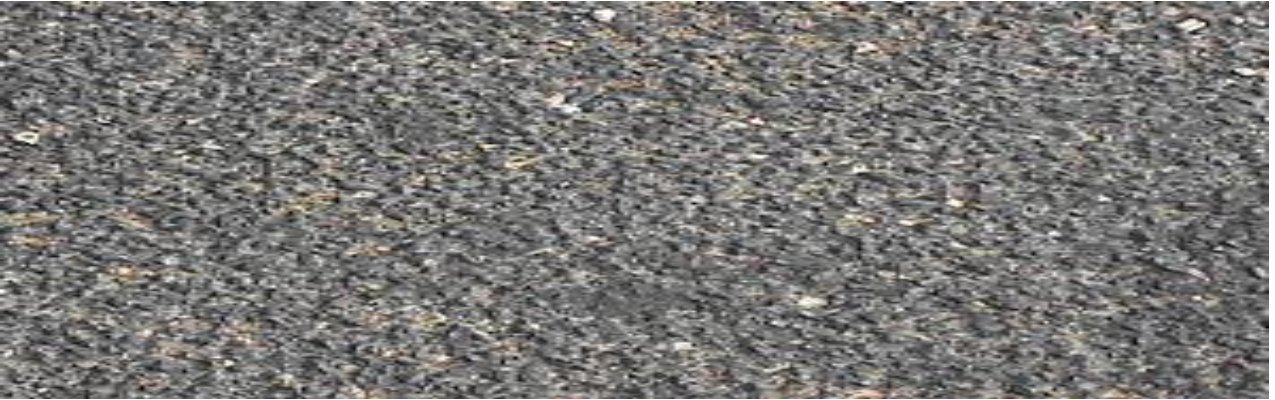
الشكل رقم (٤٨) يوضح شدة متوسطة للتطاير والتآكل
