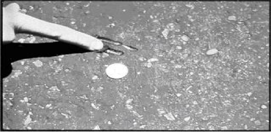
الشكل رقم (٤٥) يوضح شدة متوسطة للنزف الاسفلتي
