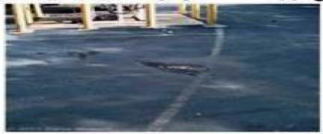
الشكل رقم (٨٦) يوضح شدة متوسطة للهبوط
