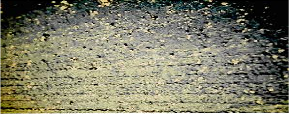
الشكل رقم (٤٦) يوضح شدة عالية للنزف الاسفلتي
