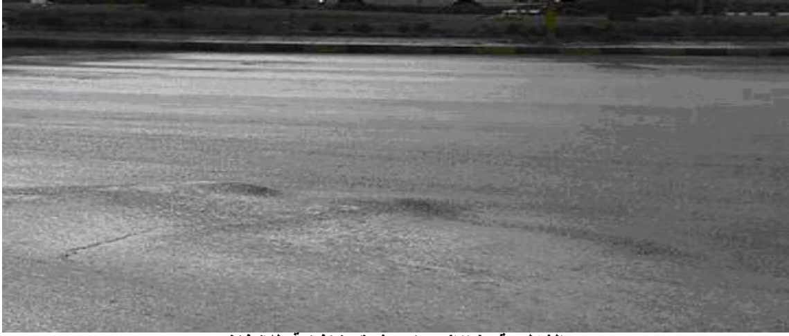
الشكل رقم (٧٦) يوضح شدة منخفضة للانتفاخ
