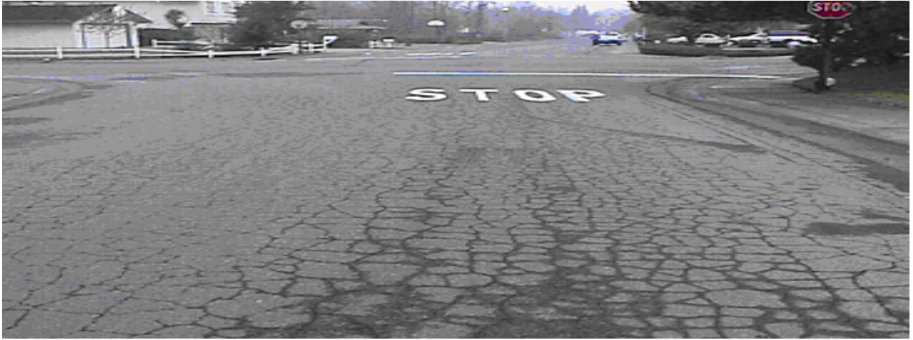
شكل رقم (١٩) يوضح الشدة العالية للشقوق التمساحية
