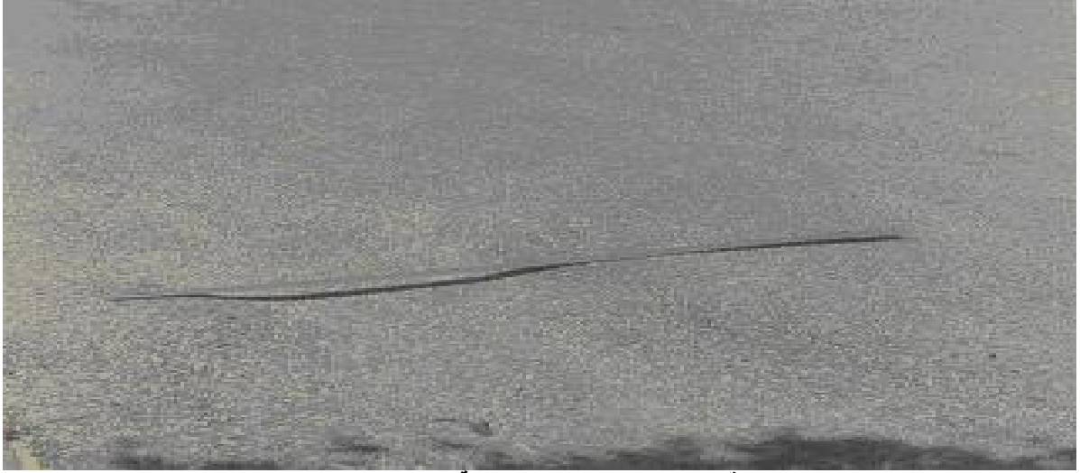
الشكل رقم (٥٢) يوضح شدة منخفضة للتحديات والتقعات
