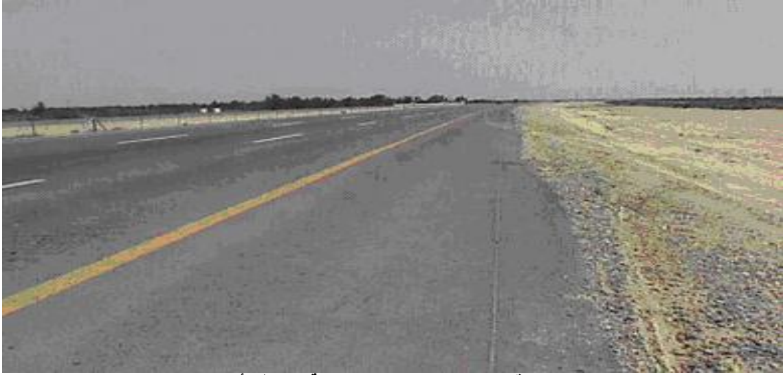
الشكل رقم (٦٨) يوضح شدة منخفضة لهبوط الأكتاف
