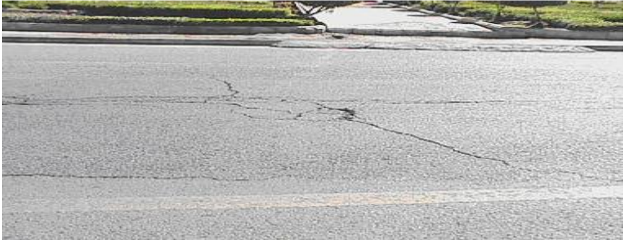
شكل رقم (٢٧) يوضح شدة عالية للشقوق الطولية
