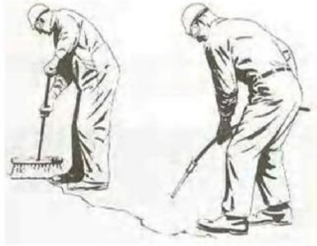
الشكل رقم (١٤٤) يوضح تنظيف شق خارجي بالمكنسة والهواء
