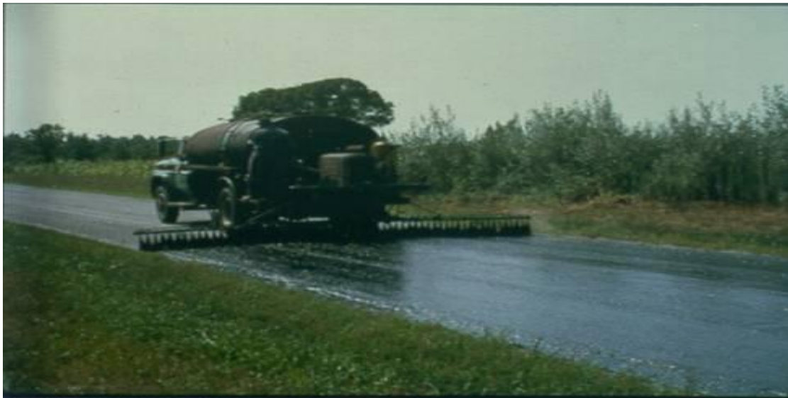
الشكل رقم (١٥٢) يوضح كيفية إجراء عملية العزل الاسفلتي
