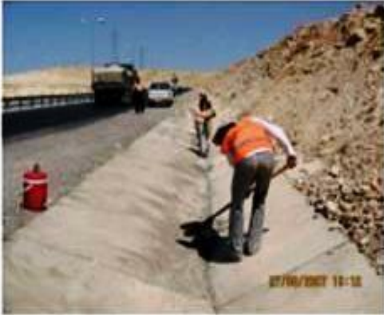
الشكل رقم (٦) يوضح كيفية إجراء عملية تنظيف الخنادق المفتوحة
