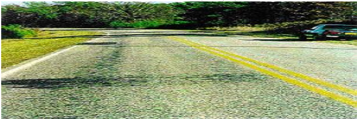
الشكل رقم (٤٤) يوضح شدة منخفضة للنزف الإسفلتي
