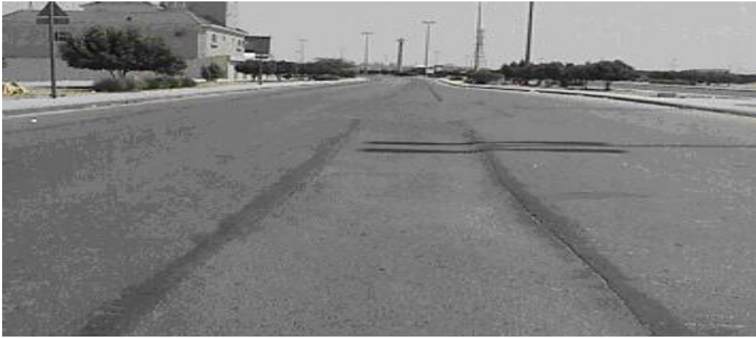
الشكل رقم (٨٤) يوضح شدة متوسطة لرقع حفريات الخدمات
