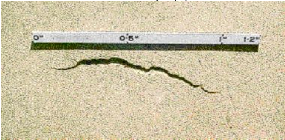
الشكل رقم (٧٣) يوضح شدة متوسطة للشقوق الإنزلاقية
