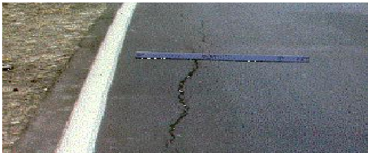
الشكل رقم (٦١) يوضح شدة متوسطة للشقوق الجانبية
