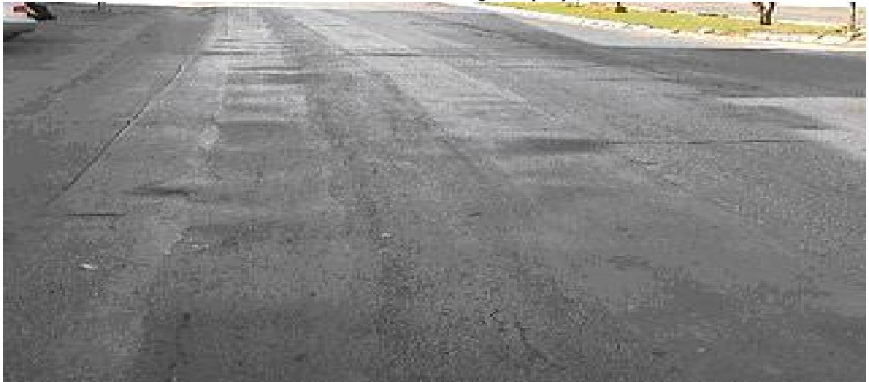
الشكل رقم (٥٣) يوضح شدة متوسطة للتحديات والتقعات
