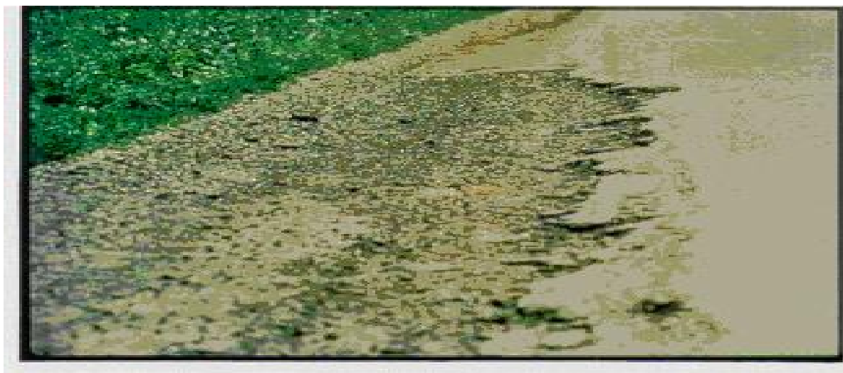
الشكل رقم (٦٢) يوضح شدة عالية للشقوق الجانبية
