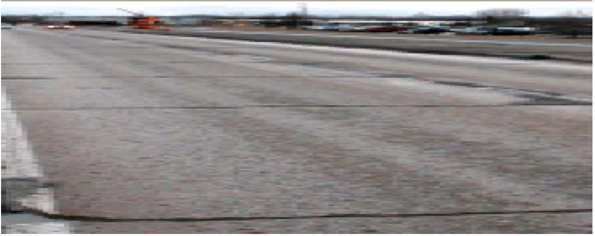
الشكل رقم (٨٩) يوضح التشققات الحرارية
