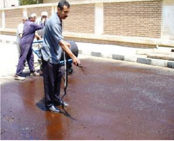
الشكل رقم (٨) يوضح طريقة رش سطح الطريق بمستحلب أسفلتي
