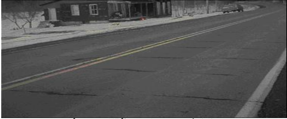
الشكل رقم (٦٥) يوضح شدة متوسطة للشقوق الانعكاسية
