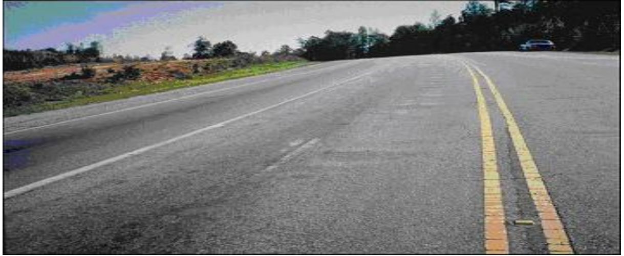
الشكل رقم (٥٦) يوضح شدة منخفضة للتموجات
