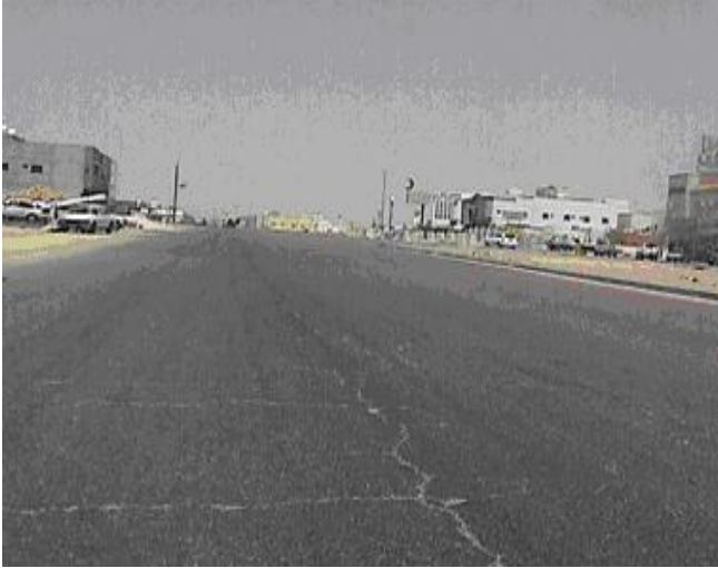
شكل رقم (٢٦) يوضح شدة متوسطة للشقوق الطولية
