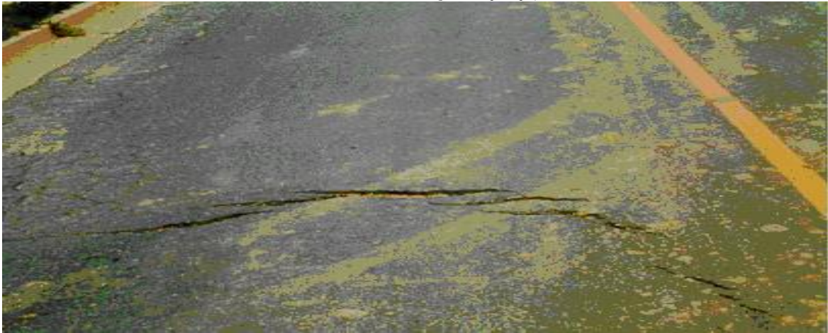
الشكل رقم (٧٤) يوضح شدة عالية للشقوق الإنزلاقية
