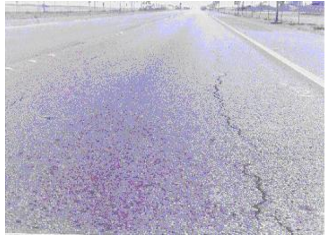
شكل رقم (١٧) يوضح الشدة المنخفضة للشقوق التمساحية
