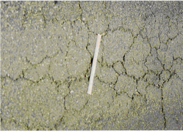
شكل رقم (١٨) يوضح الشدة المتوسطة للشقوق التمساحية
