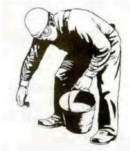
الشكل رقم ( ١٤٦ ) يوضح وضع الرمل على شق مملوء بمستحلب إسفلت
