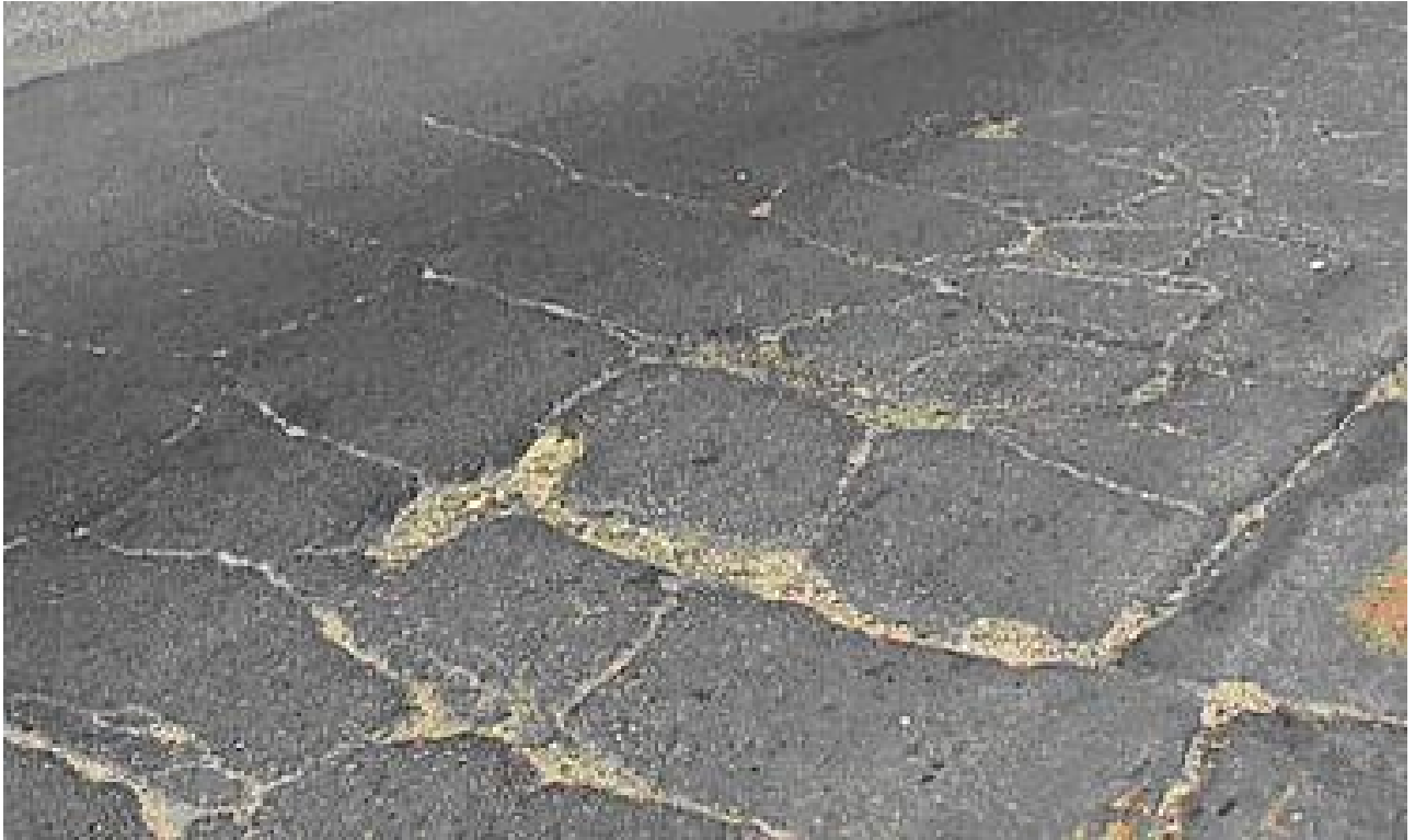
شكل رقم (٢٣) يوضح شدة عالية للشقوق الشبكية
