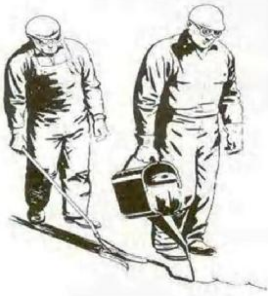
الشكل رقم ( ١٤٥ ) يوضح صب وتنظيف المستحلب
