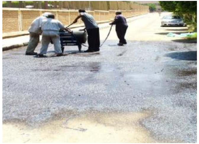
الشكل رقم (٨) يوضح طريقة رش سطح الطريق بمستحلب أسفلتي
