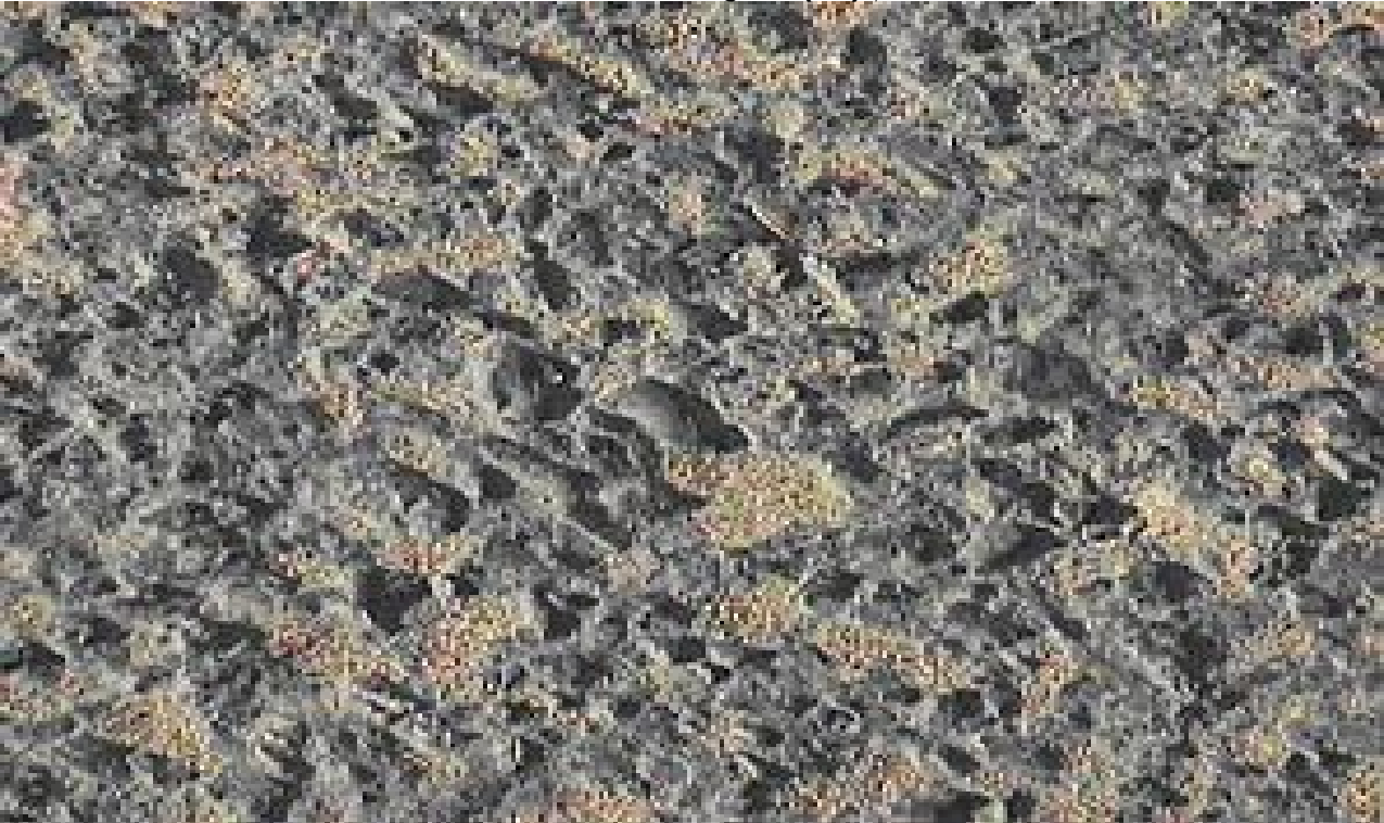
الشكل رقم (٤٩) يوضح شدة عالية للتطاير والتآكل
