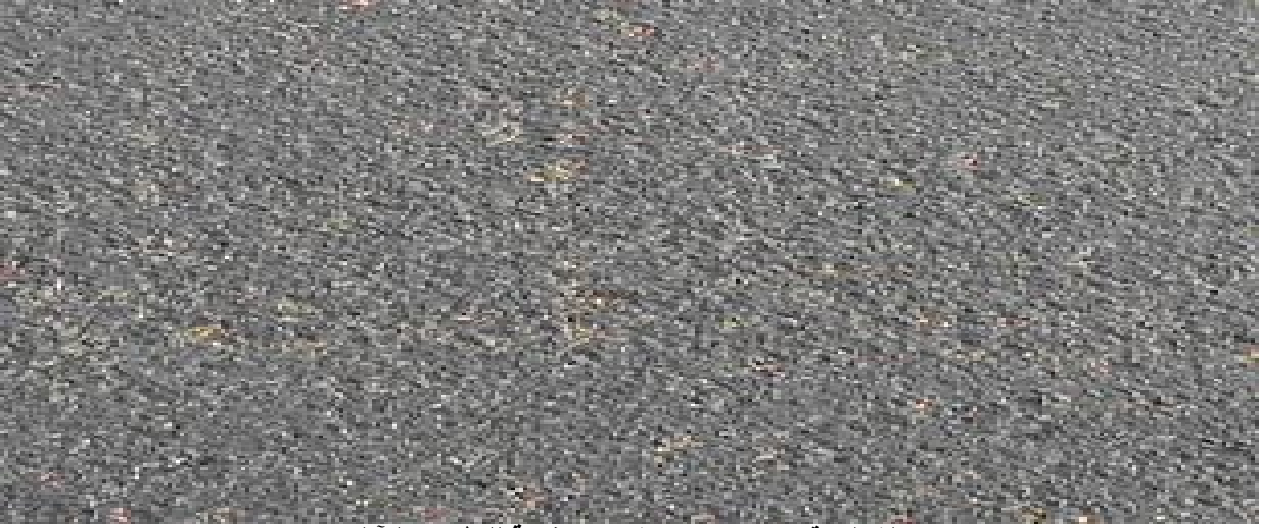
الشكل رقم (٤٧) يوضح شدة منخفضة للتطاير والتآكل
