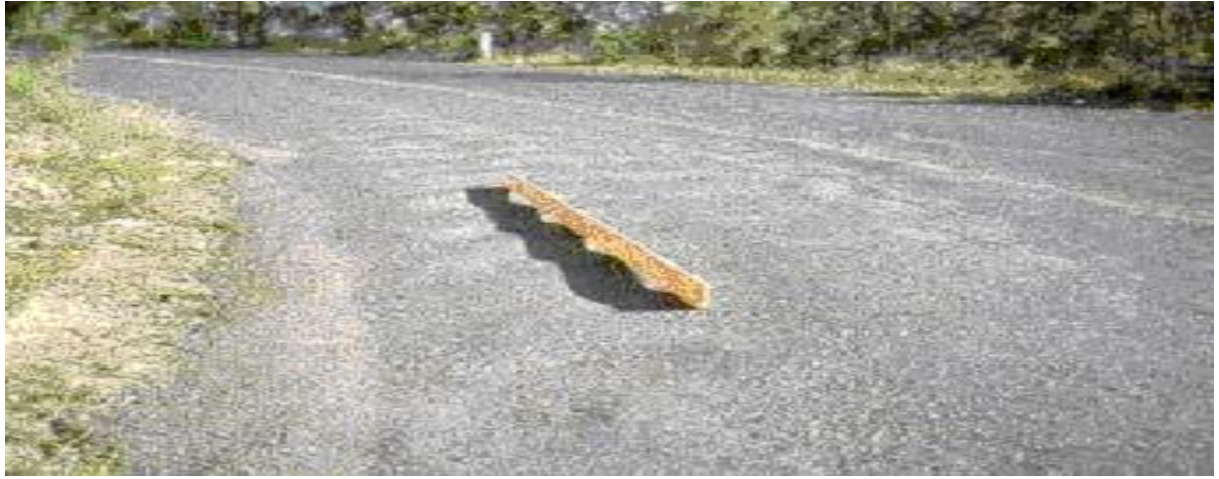
الشكل رقم (٥٧) يوضح شدة متوسطة للتموجات
