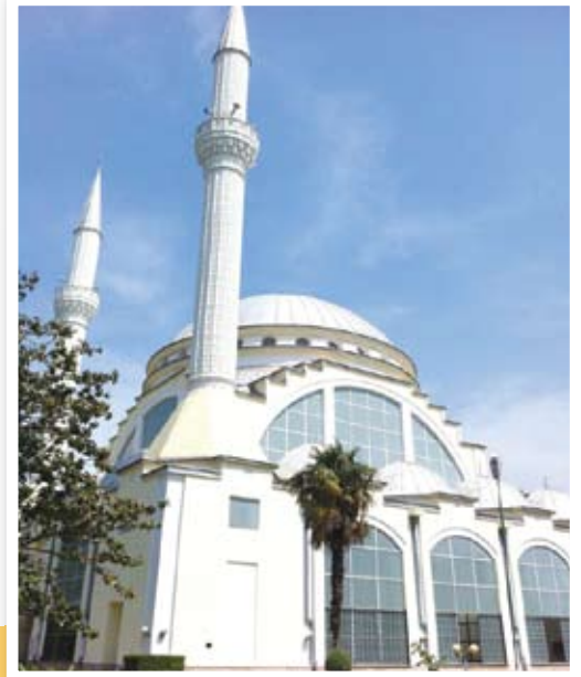
مسجد في وسط شكودرا في ألبانيا وقد بناه تاجر ألباني
