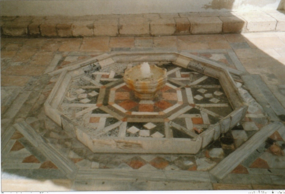
شكل(6-7): شدروان ثماني من الرخام المقسم هندسيا، في احد الأفنية في قصر آل النمر بالبلدة القديمة، المصدر: ( روفو،2002،ص: 12) .
