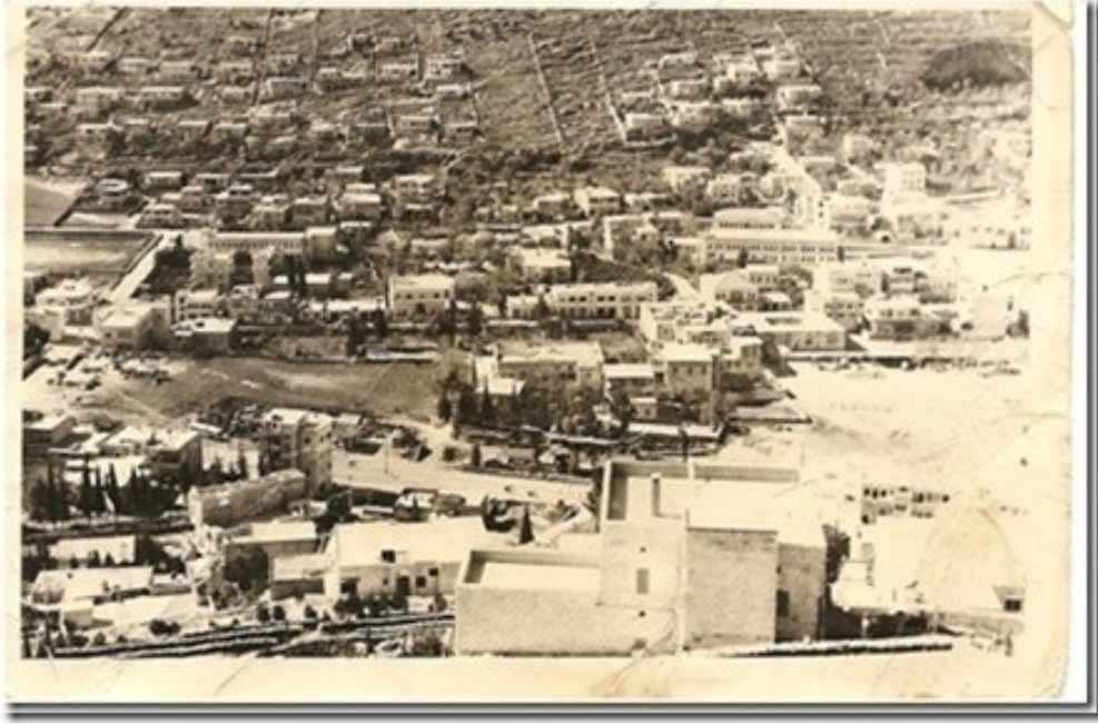
شكل(6-9) : صورة لجزء من مدينة نابلس التقطت عام 1950 ويظهر فيها نظام البناء المتبع على شكل مباني منفصلة تحيطها حدائق مسورة ، المصدر : ( www.nablus.gov.ps ) .
