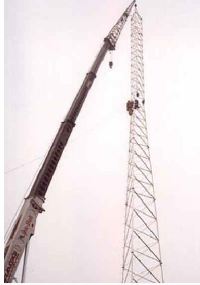
شكل 9: استخدام رافعة لتركيب الجزء العلوي من برج مرتفع مدعوم ذاتياً.
