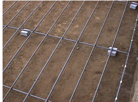
شكل 6: أ) استخدام القواعد البيتونية لرفع القضبان الفولاذية عن سطح التربة ب) استخدام الأسلاك لتربط القضبان الفولاذية على شكل شبكة
