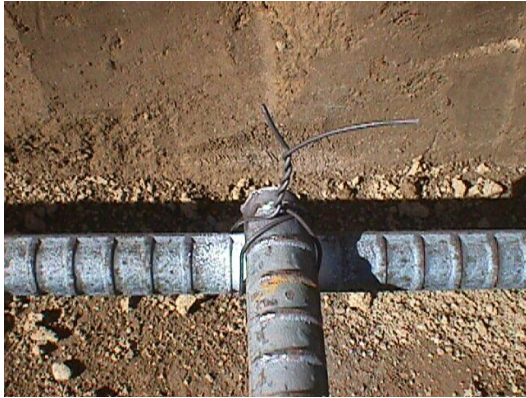
شكل 6: أ) استخدام القواعد البيتونية لرفع القضبان الفولاذية عن سطح التربة ب) استخدام الأسلاك لتربط القضبان الفولاذية على شكل شبكة
