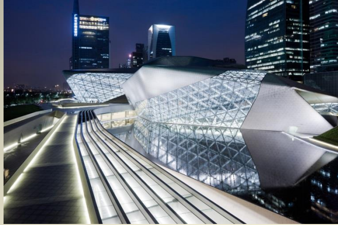
التكسيات المعدنية للمبنى بأكملة مع الزجاج المزوج العازل
