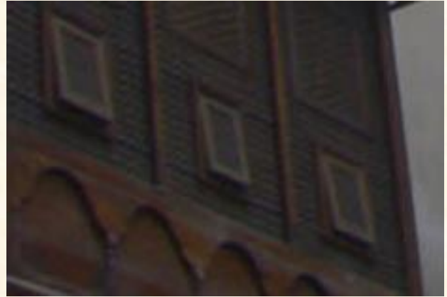
صورة لغرفة استخدمت فيها المشربيات لإضاءتها وتهويتها ببيت السحيمى
