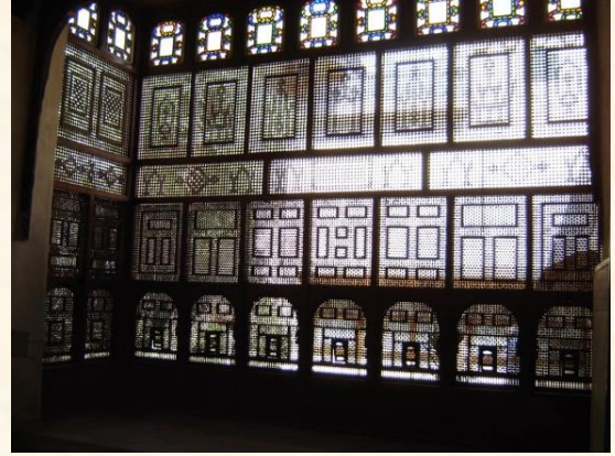
صورة لغرفة استخدمت فيها المشربيات لإضاءتها وتهويتها ببيت السحيمى
