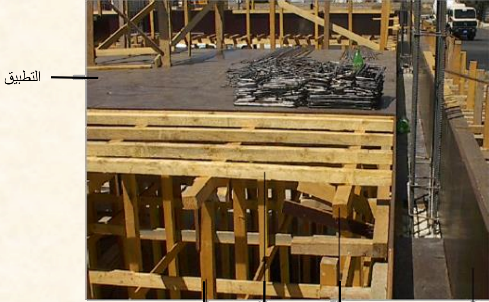
صورة تبين بدء عمليه التطبيق للسقف تمهيدا لعمليات الحدادة عرقات السقف التطريح قوائم رأسية
