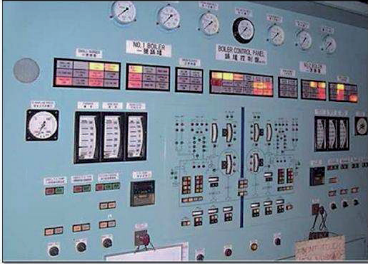
الشكل رقم (3-155) لوحة السيطرة على المراجل البخارية النوع التقليدي
