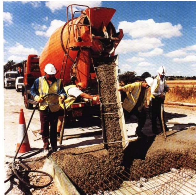
شكل (٨-٤) صب خرسانة جافة نسبياً تحتاج إستخدام الهزاز وقت أكبر.
