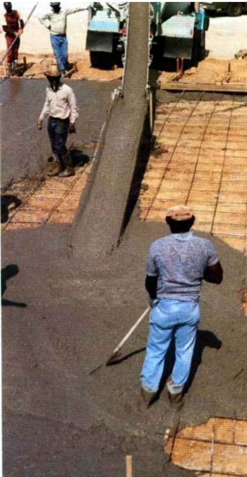
شكل (٩-٤) صب خرسانة عالية السيولة والإنسيابية لاحتياج إستخدام الهزاز
