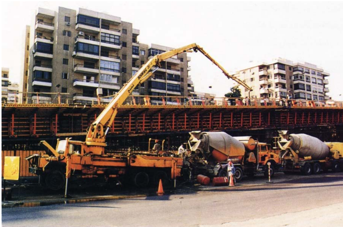
شكل (٥-٤) إستخدام عربات خلط ونقل الخرسانة و طلمبة الضخ في صب أحد مراحل كوبرى ٦ أكتوبر.
