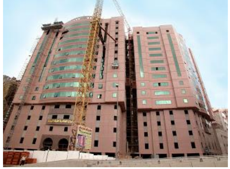
احدى العمائر اثناء التكسيه بالرخام
