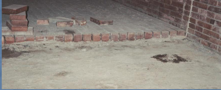
تغطية الأرضيات بالطوب الحراري
