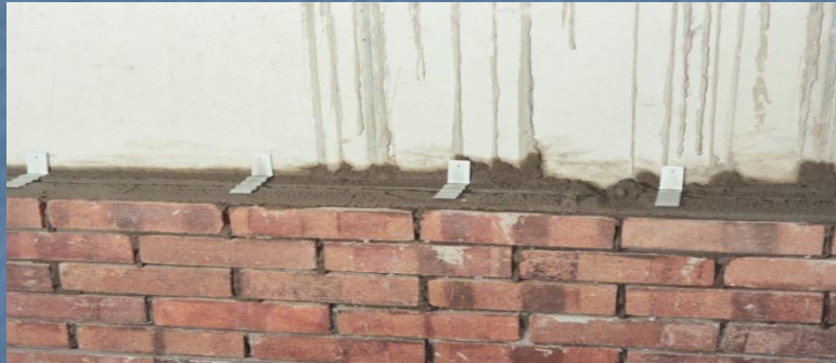
تثبيت حائط الكسوة بحائط الخرسانة بالكانات
