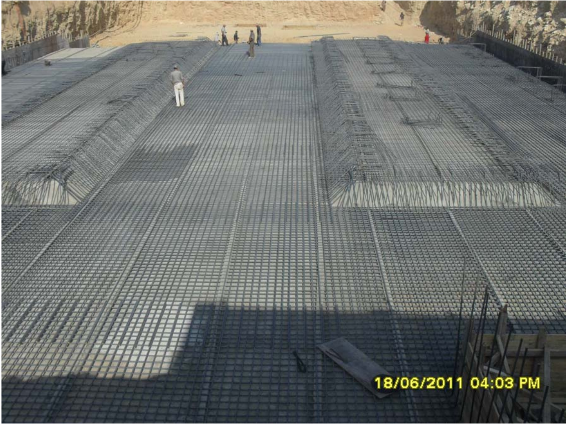
وبعد الانتهاء من التسليح السفلى للخزان نقوم بعمل كراسي لوضع التسليح العلوى
