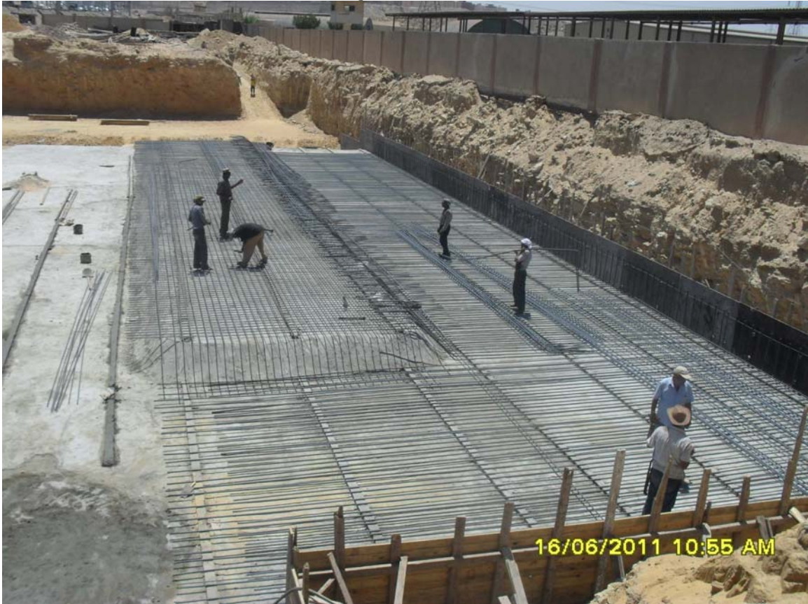
وهذه صورة عامة لاجارى عمل تسليح القواعد المسلحة للخران
