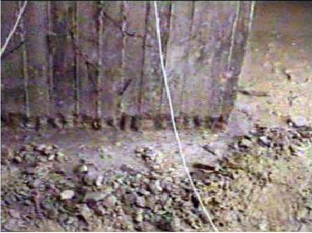
صورة توضح تكسير التقاء العمود بالأرضية في البدروم
