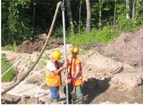
يتم تركيب هذا النظام بسرعة وسهولة وهذه أهم ميزة فيه فيتم توصيل الحربة بطلمبة لضغط المياه (تعطي ضغط حوالي ٦ بار وتصرف ٢٠ لتر/ث) ويتم غرسها في التربة فتتنزل الحربة في الأرض بسهولة جدا تحت تأثير ضغط المياه التي تخرج من أسفل الحربة والتي تجعل الرمل في حالة غليان وطالما كانت التربة رملية تسمر يسمر نزول الحربة
