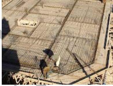
13 - يقوم الكهربائي والسباك وفني التكييف بعمل كمال التجهيزات اللازمة والتوصيلات الكهربائية المطلوبة للسقف .
