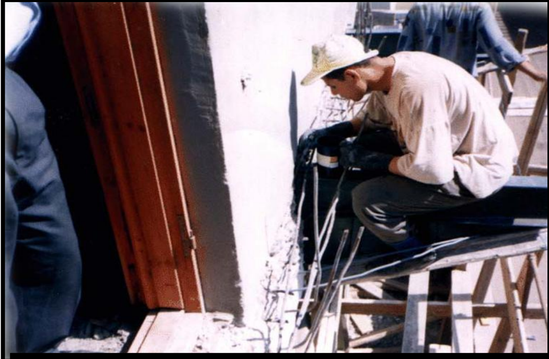
استخدام مادة كيمابوكسي (165) لزيادة تماسك الحديد مع الخرسانة
