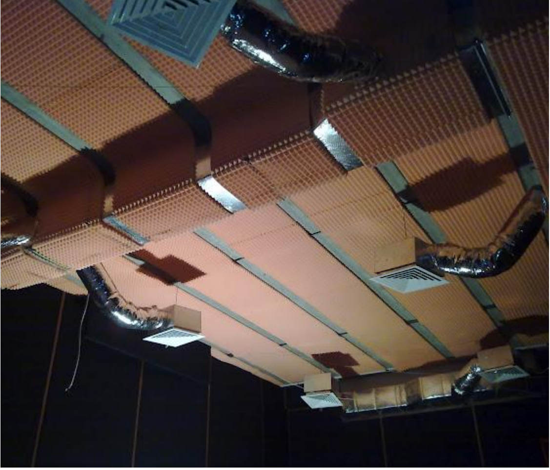
تركيب الواح الامتصاص الصوتي و منع الصدى بسقف الاستوديو
