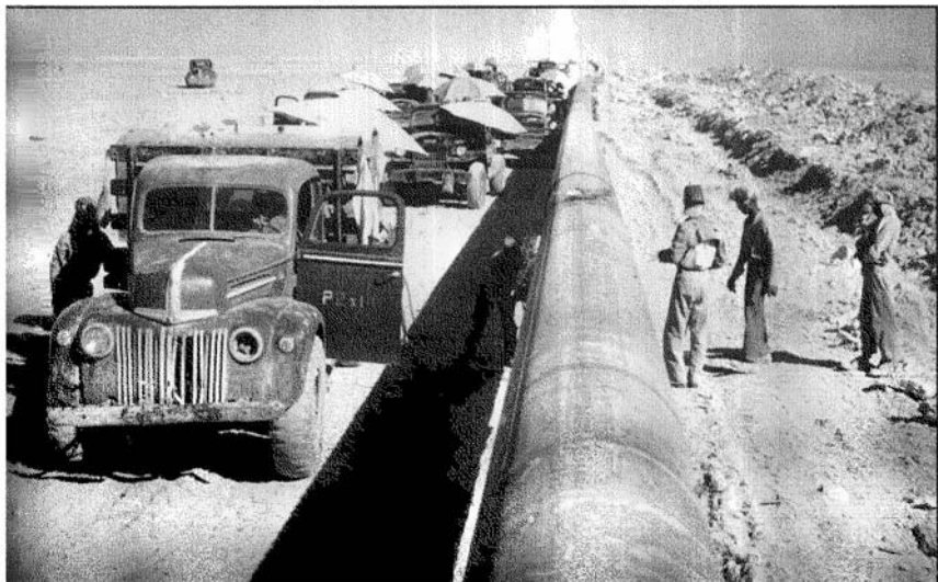
الصورة رقم (٧): خط الأنابيب (التابلاين) تحت الإنشاء.
