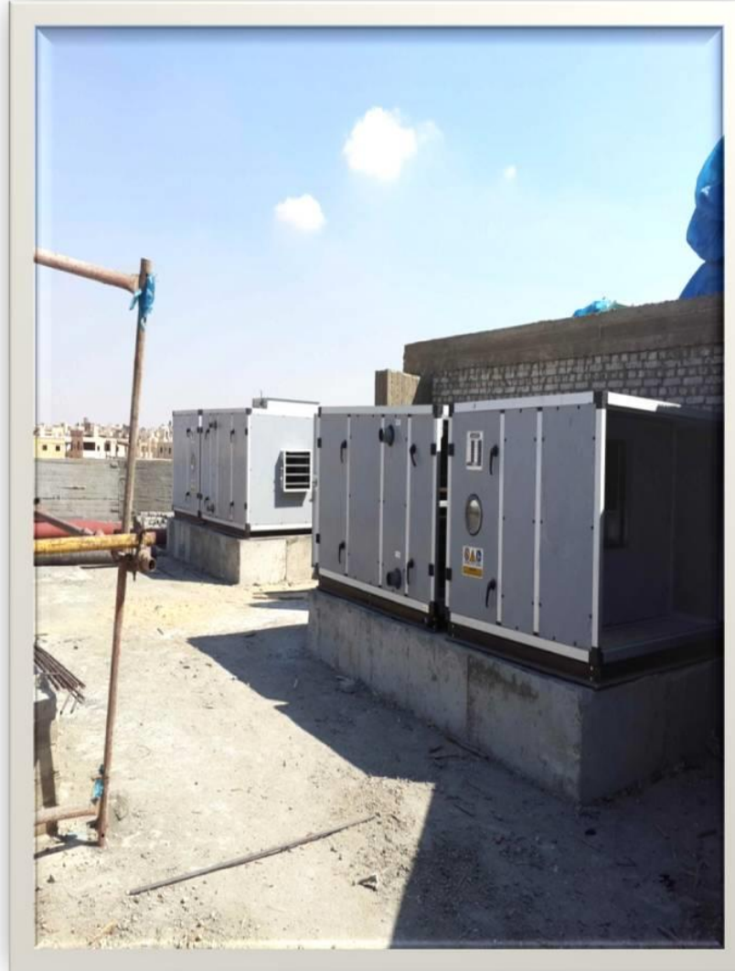
تركيب وحدات مناولة الهواء
