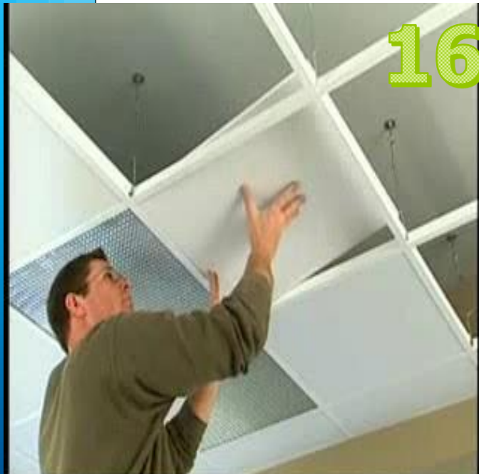
تركيب البلاطات الجبسية فوق الزوايا
