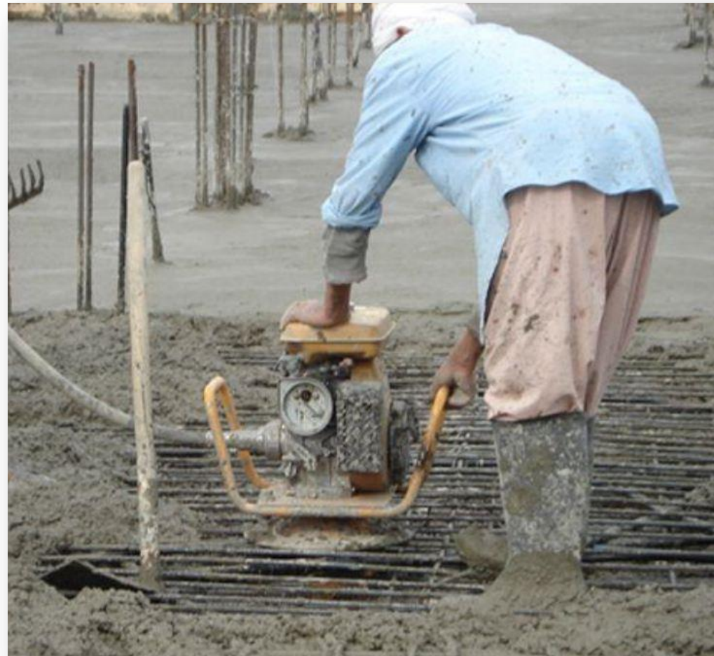
استخدام الهزاز لمنع التعشيش في الخرسانة
