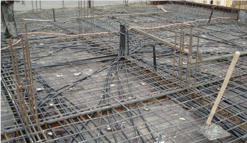
تسليح الاسقف وفرش خراطيم الكهرباء قبل صب السقف
