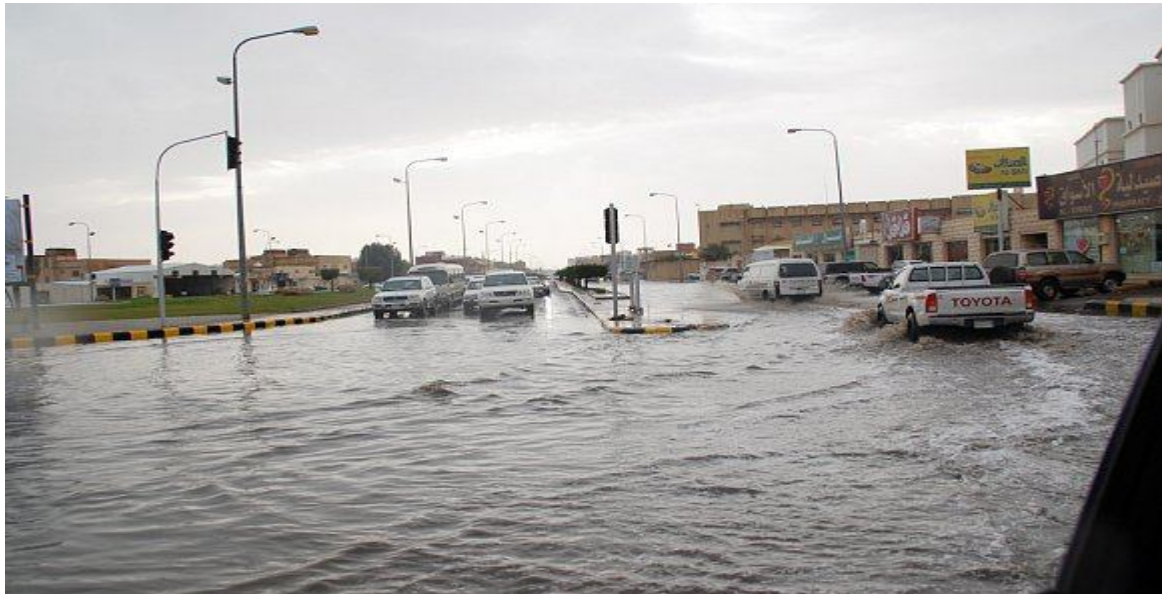
الشكل رقم (٣١) يوضح أثر عدم تصريف مياه الأمطار على الطرق
