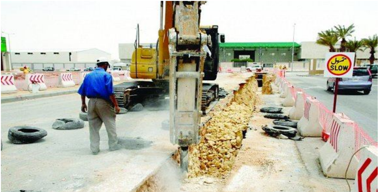
الشكل رقم (٨١) يوضح كيفية تنفيذ حفر الخندق
