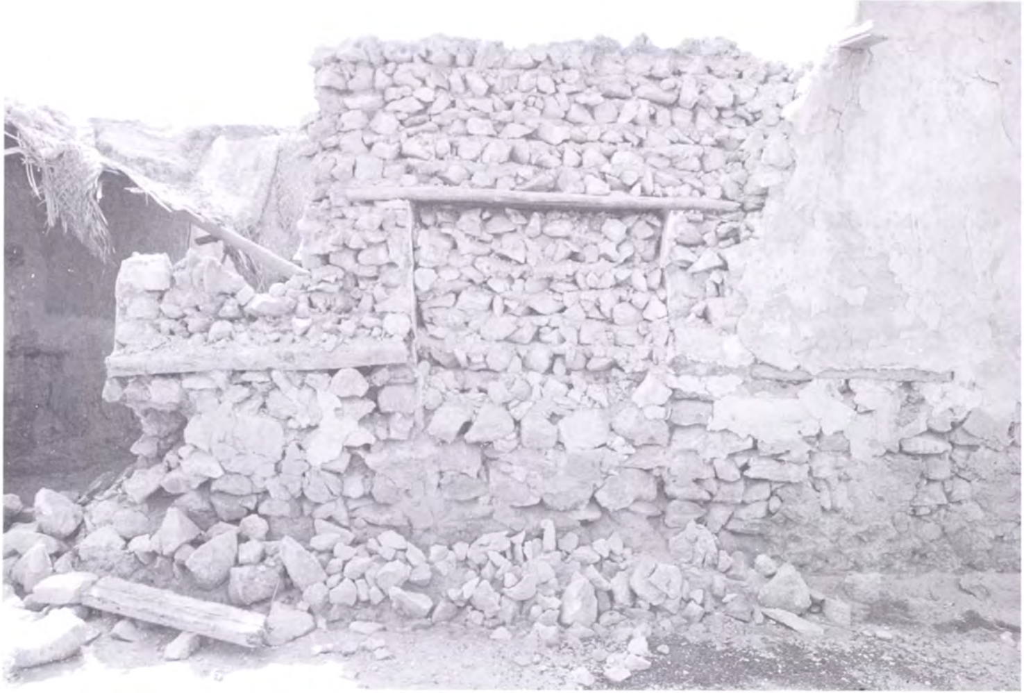
(شكل ٧٥) جسور من خشب الدنشل وجذوع النخيل في البناء التقليدي.
