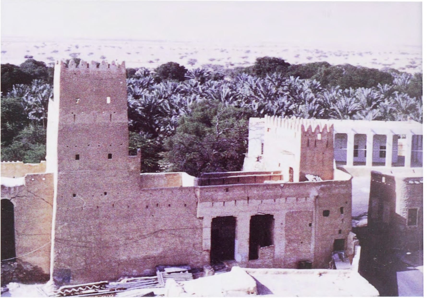
(شكل ٣٤) الجهة الشمالية من قلعة محمد بن جاسم بأم صلال محمد ١٩٨٦م.
