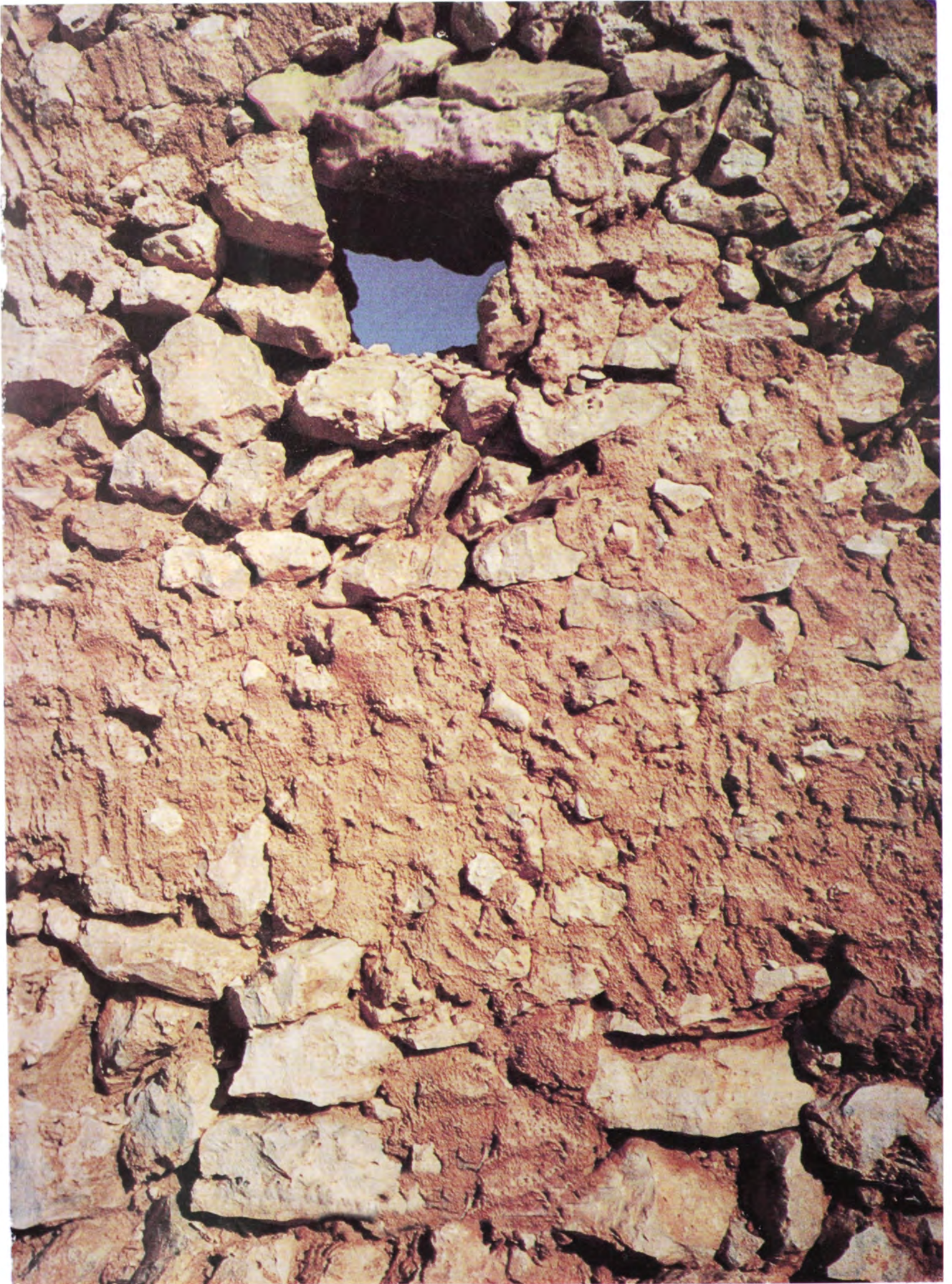
(شكل ٣) أثر العوامل الجوية على المباني التقليدية بقطر .
