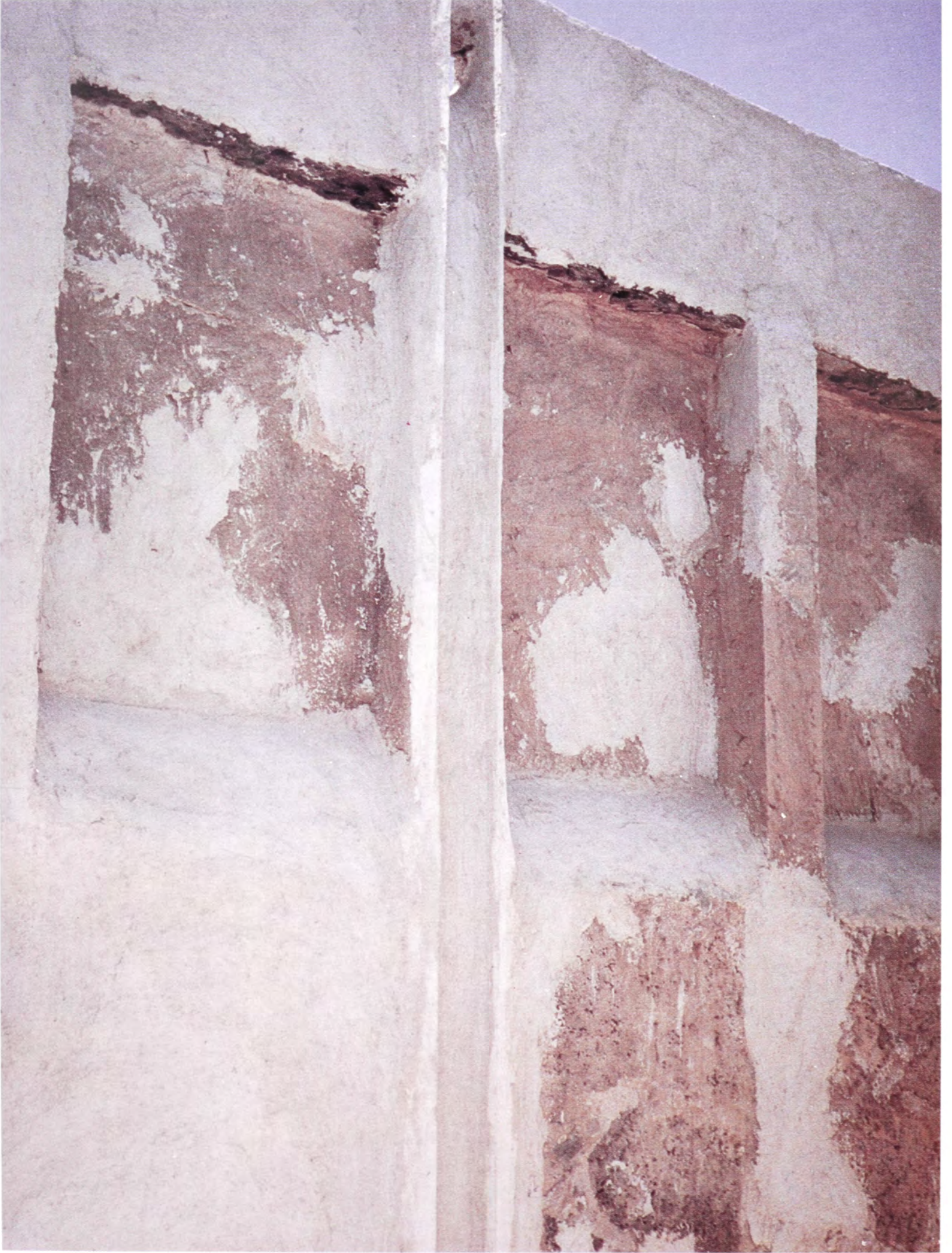
(شكل ٥٧) مرزام في الجدار الخارجي للغرفة.
