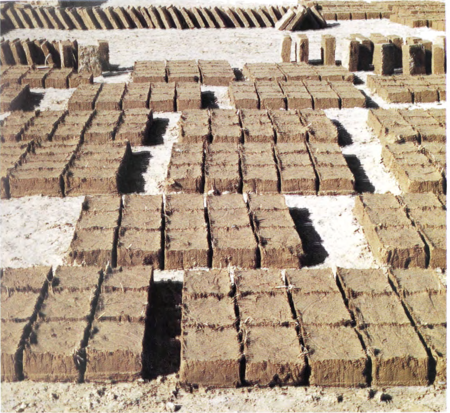
(شكل ١٠٧) عملية تجفيف الطابوق اللبن تمهيداً لاستخدامه في أعمال الترميم.
