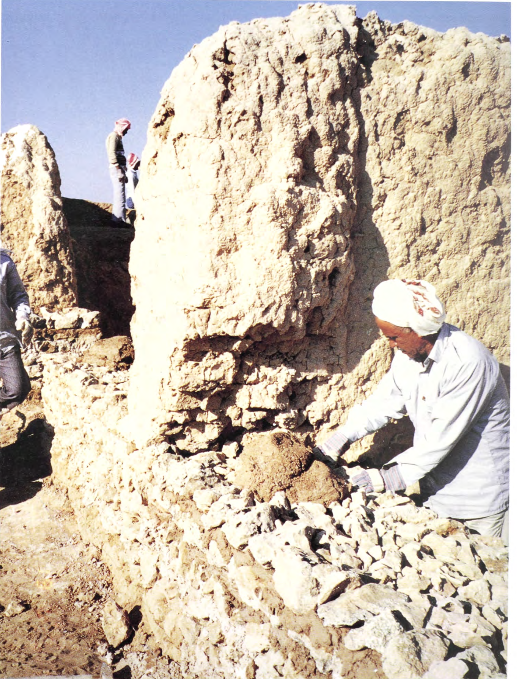
(شكل ٨٩) عملية بناء المداميك الحجرية بالطين المخلوطة بالجص والنورة والرمل المغسول (قلعة اركيات) بقطر.
