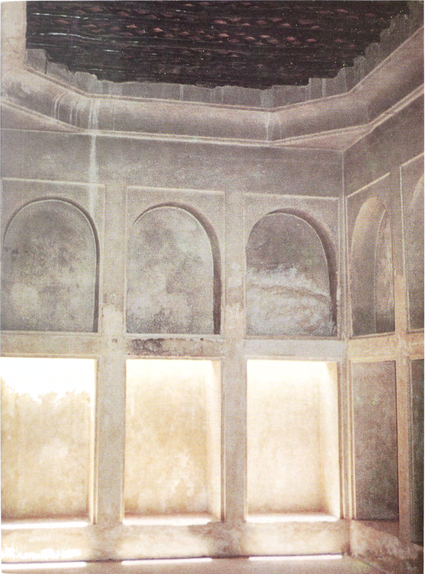
(شكل ٨٠) الدخلات الجدارية من الداخل وفتحات التهوية والاضاءة في إحدى الغرف القديمة.
