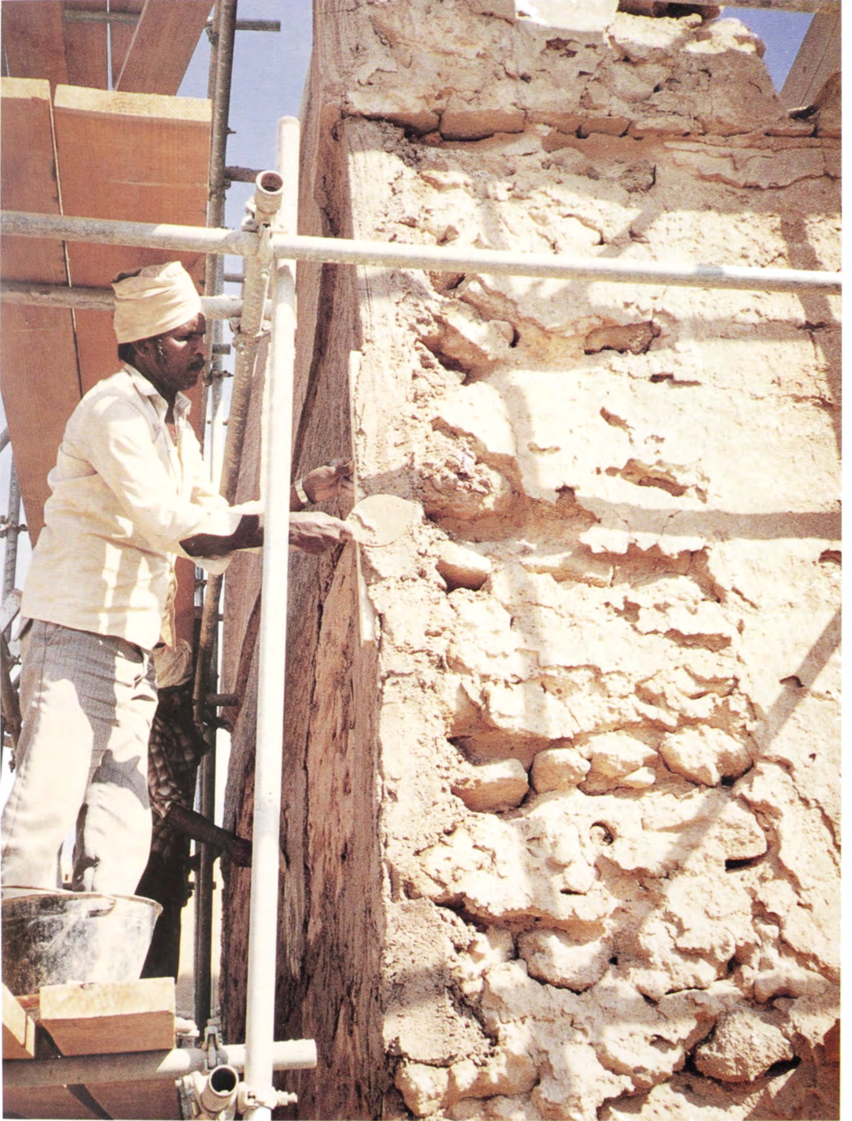
(شكل ٩٠) عملية وضع طبقة الطلاء الطينية لأحدى القلاع التاريخية.
