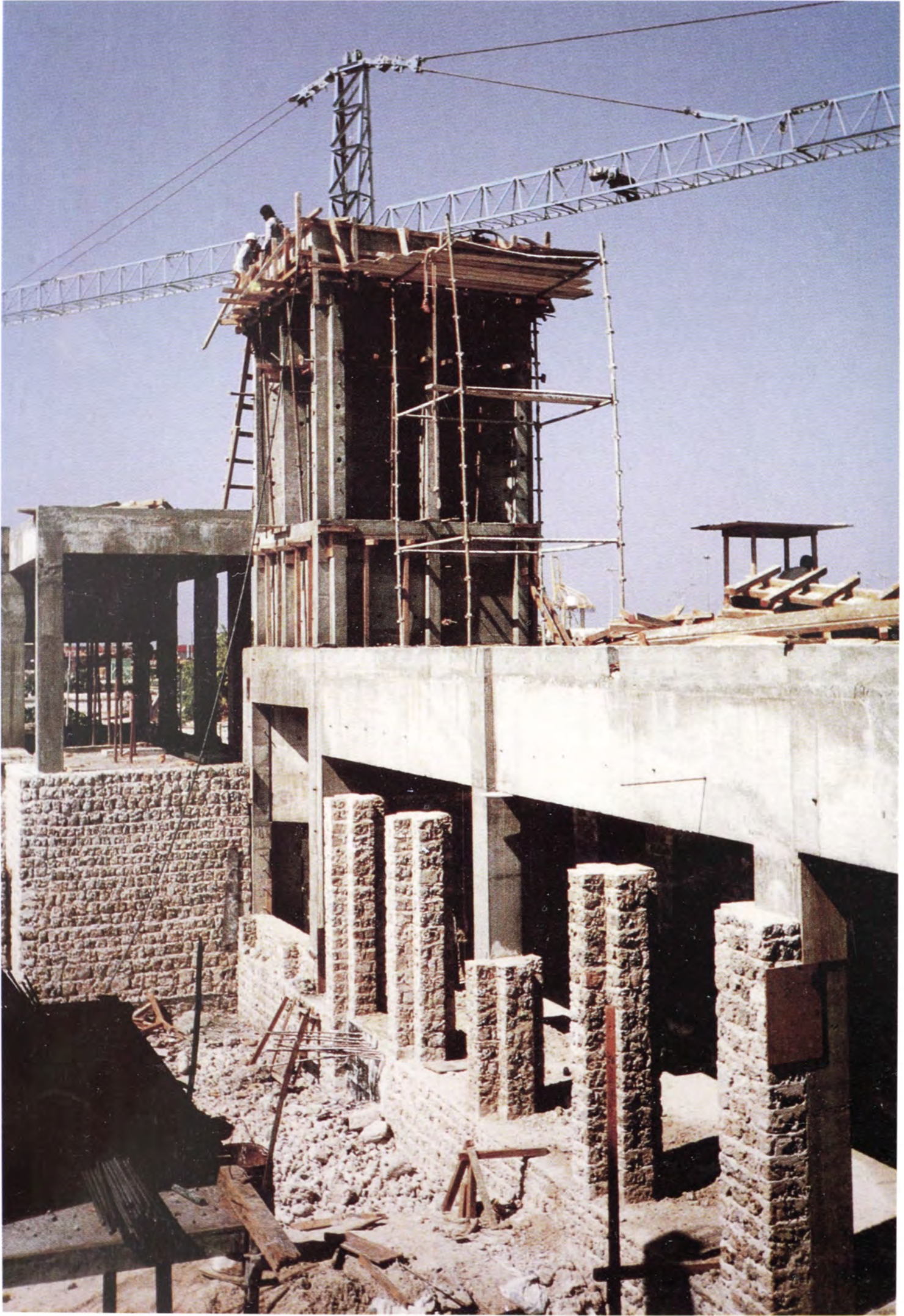
(شكل ٩٤) الهيكل المسلح ويبدو واضحاً فيها تغطية الأعمدة بالحجارة القديمة والأسمنت الابيض.
