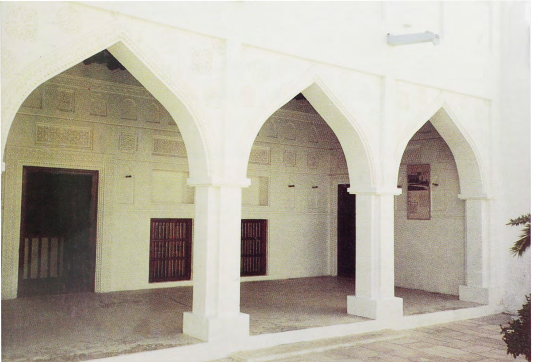
(شكل ٧١) عقود مدببة ذات الأربع مراكز بأحد مباني القصر القديم.
