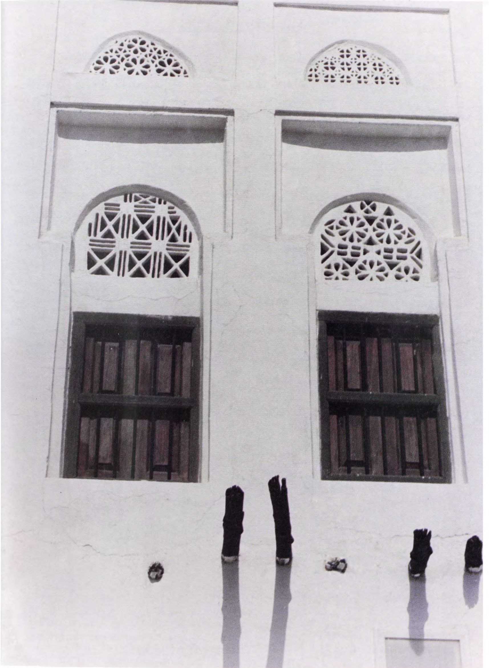
(شكل رقم ٨٥) شمسيات (قمریات) تزين واجهة أحد البيوت التقليدية المجددة - بمدينة الوكرة.
