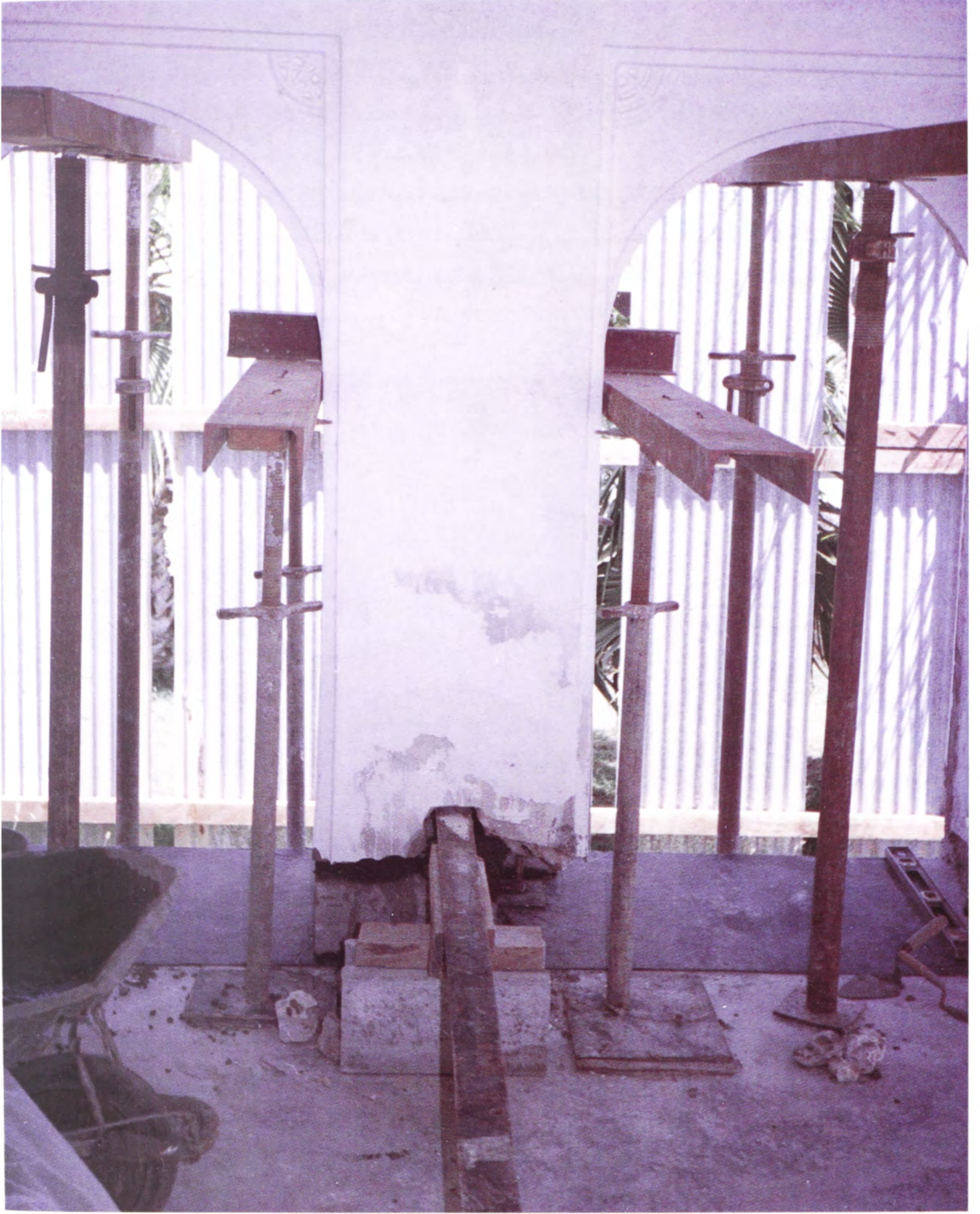
(شكل ١١٦) عملية فصل أسس المبنى عن الجدران ووضع طبقة العازل المطاطية لمنع صعود الرطوبة إلى أعلى. بمتحف قطر الوطني .
