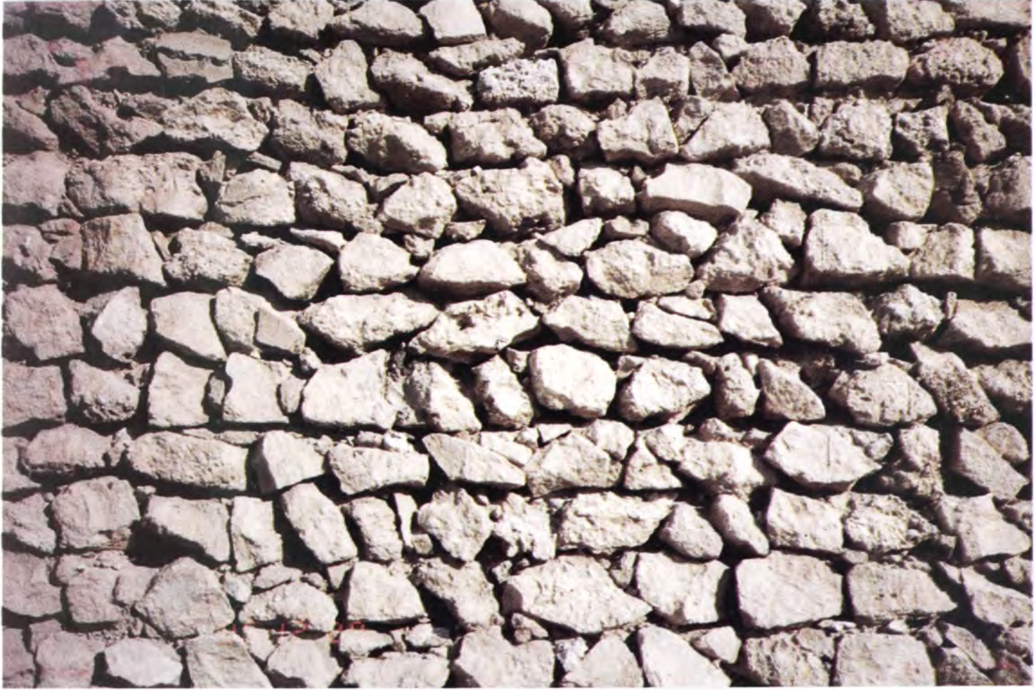
(شكل ١٠٥) جدار مبنى من الحجر الجيري المقطوع من التلال الصخرية.
