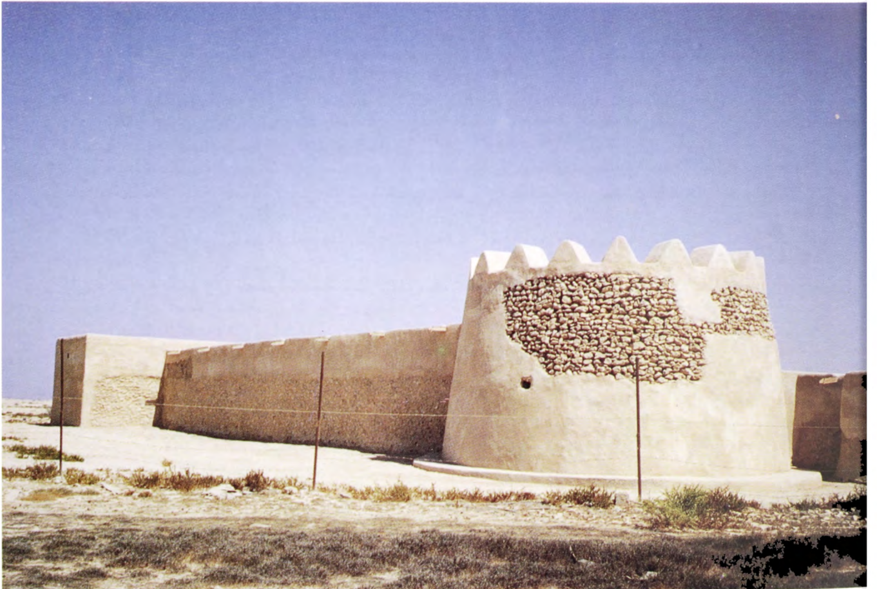
(شكل ٢٥) القلعة بعد الانتهاء من عملية الترميم ١٩٨٨م .
