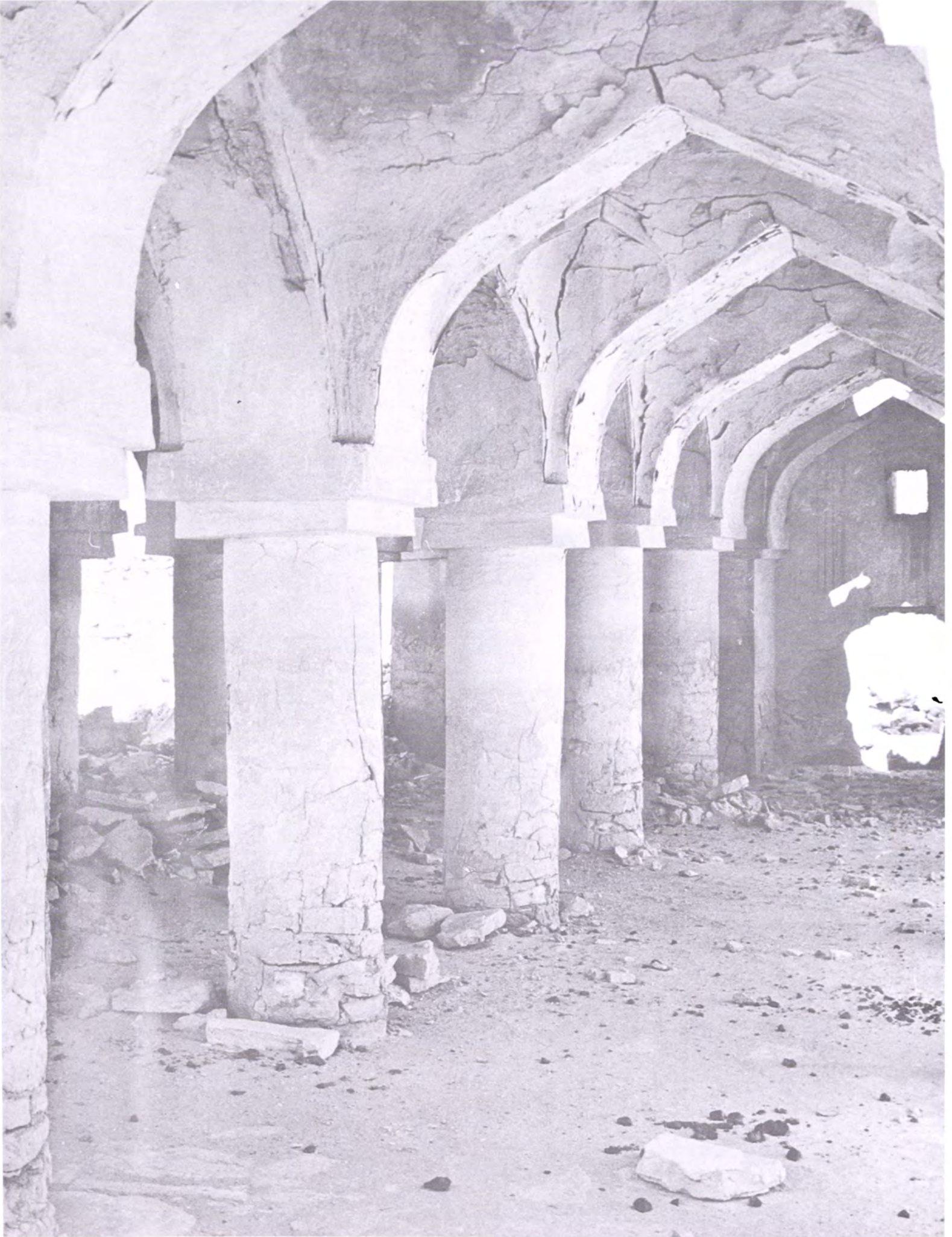
(شكل ٧) صفوف من البوائك ذات العقود المدببة القائمة على أعمدة أسطوانية حاملة للقباب التي تسقف رواق . القبلة بأحد المساجد القديمة بشمال قطر (الزيارة) التي لاوجود لها الآن.
