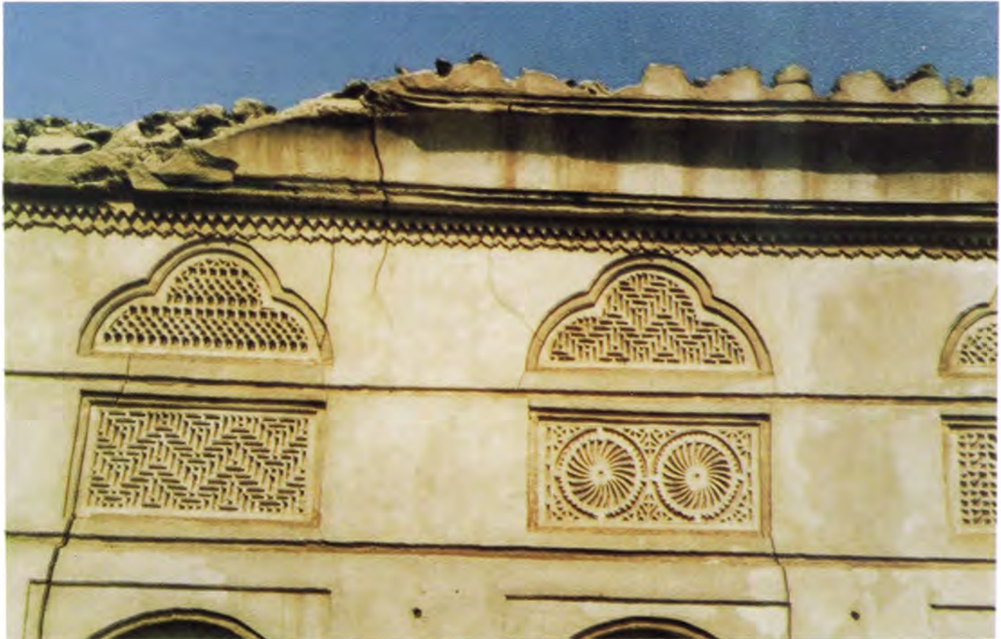
(شكل رقم ١٠١) زخارف جصية ذات موضوعات هندسية كانت بأحد البيوت القديمة بمدينة الوكرة.
