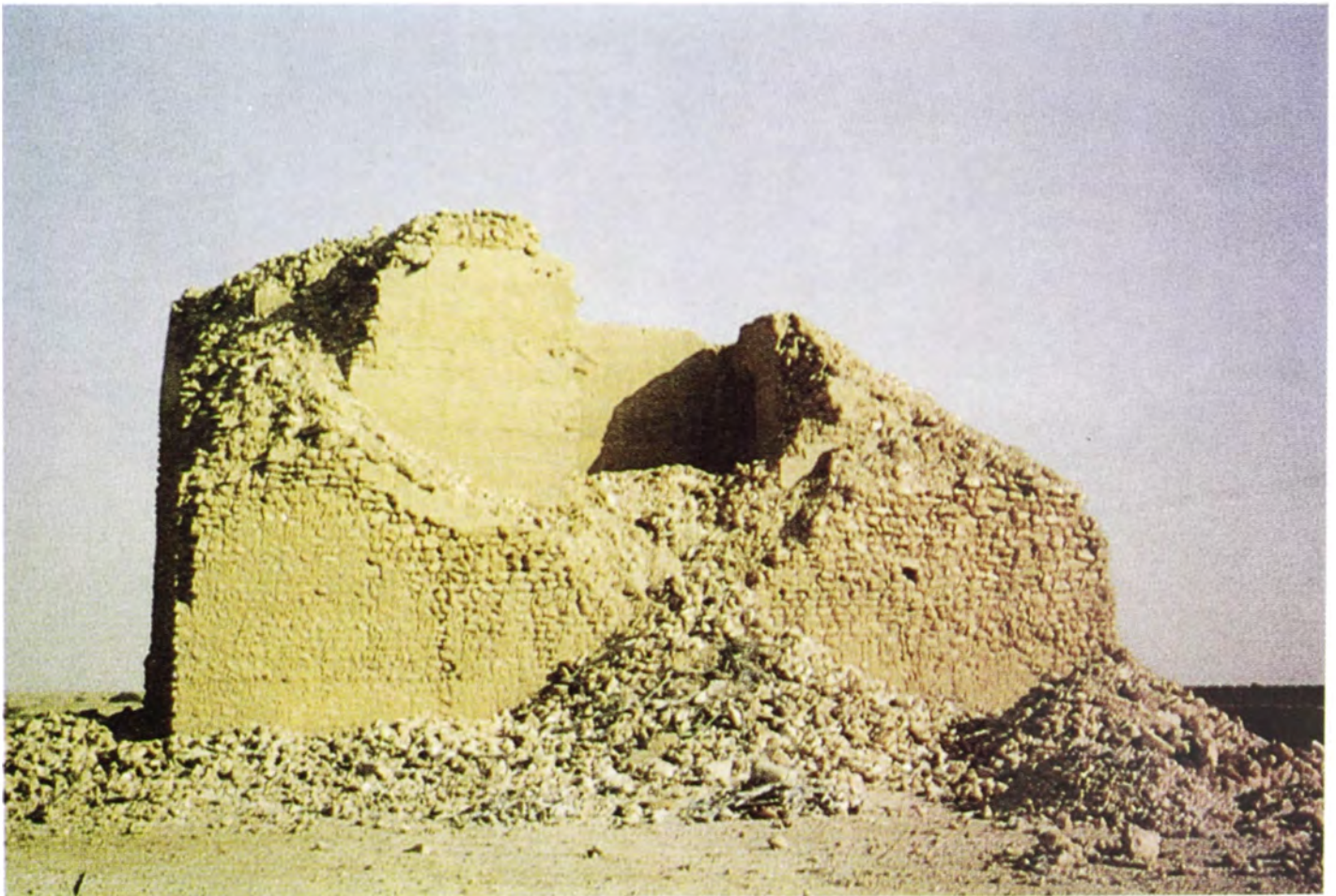
(شكل ٤٠) حالة البرج الشرقي عام ١٩٦٨م من الجهة الجنوبية.
