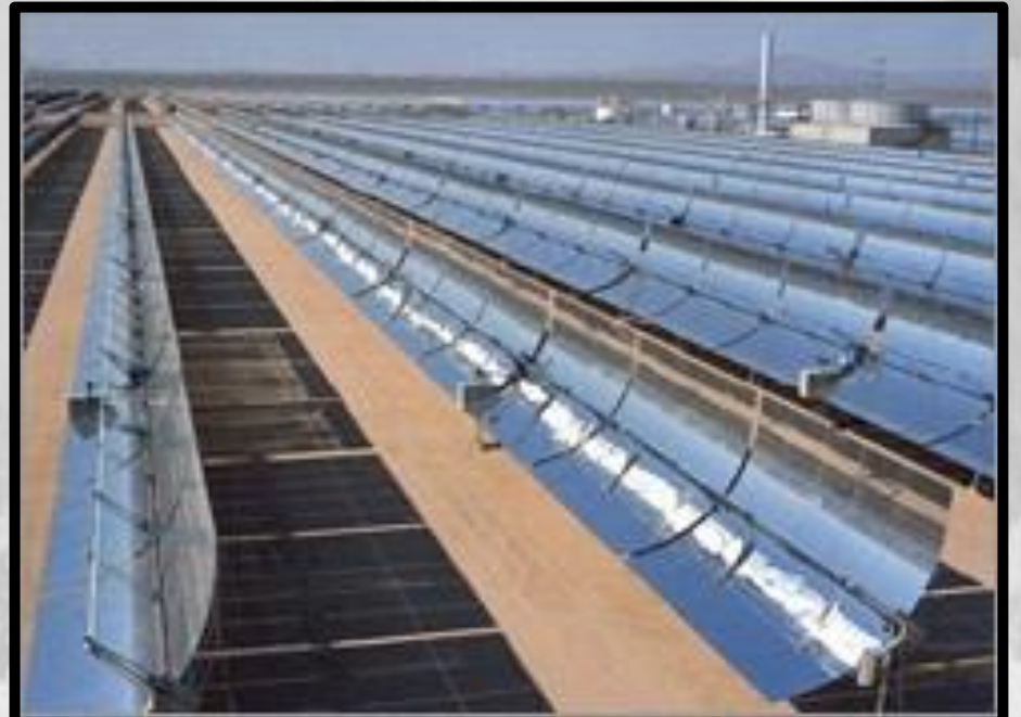
محطه تعمل بمرايا القطع المكافئ المستطيليه
