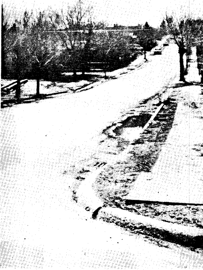
صورة (١١) انخفاض الشارع وتهدم الرصيف وتغير مجاري تصريف المياه نتيجة لانخفاض الأرض في منطقة منجم الفحم في روك سيرينج في وايمنغن بسبب استخراج الفحم بكميات كبيرة. (after, Coates, 1979)
