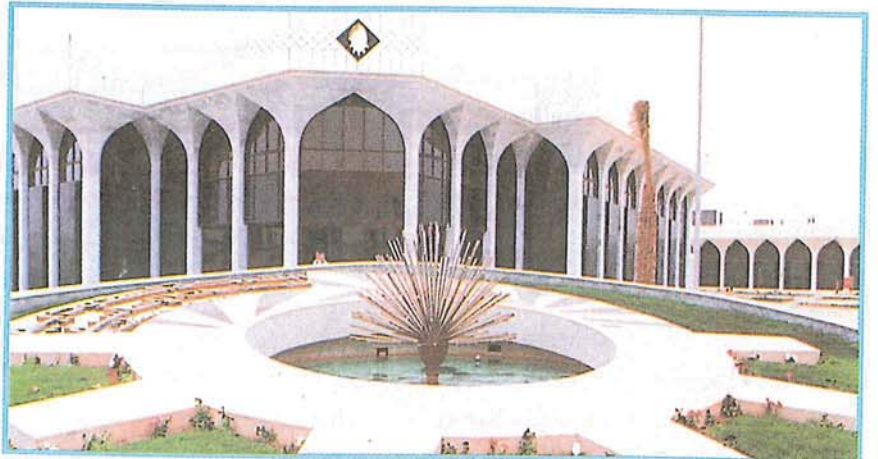
● مبنى المختبرات في مجمع سابك الصناعي .
