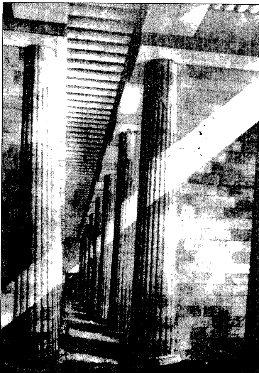
٢٣- نموذج لمدخل بهو الأساطين يبين السقف الذى يمثل الكتل والأعمدة ذات الأضلاع (عن لوير) (Lauer, op. cit. pl. XLV)
