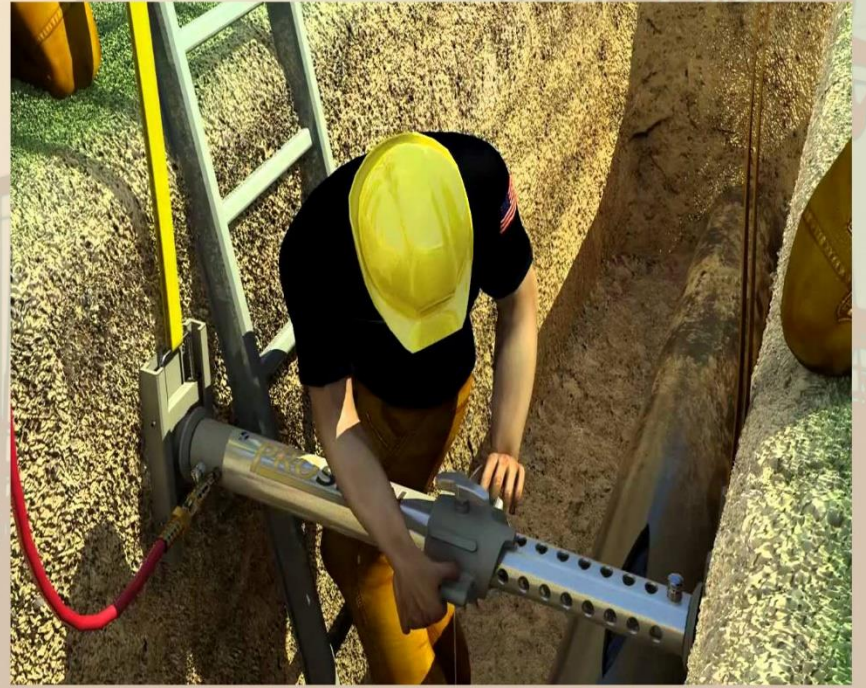
مثال اخر لتدعيم جوانب الحفر بسواند التدعيم باستخدام الهواء
