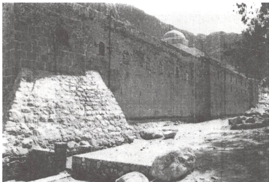
(لوحة ٦) الجدار الجنوبي الغربي المواجه لجبل موسى
