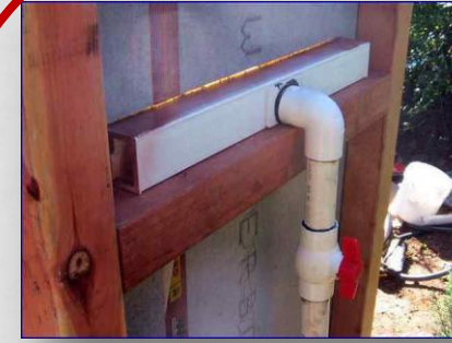
ماسورة تغذية الحائط بالماء من المضخة
