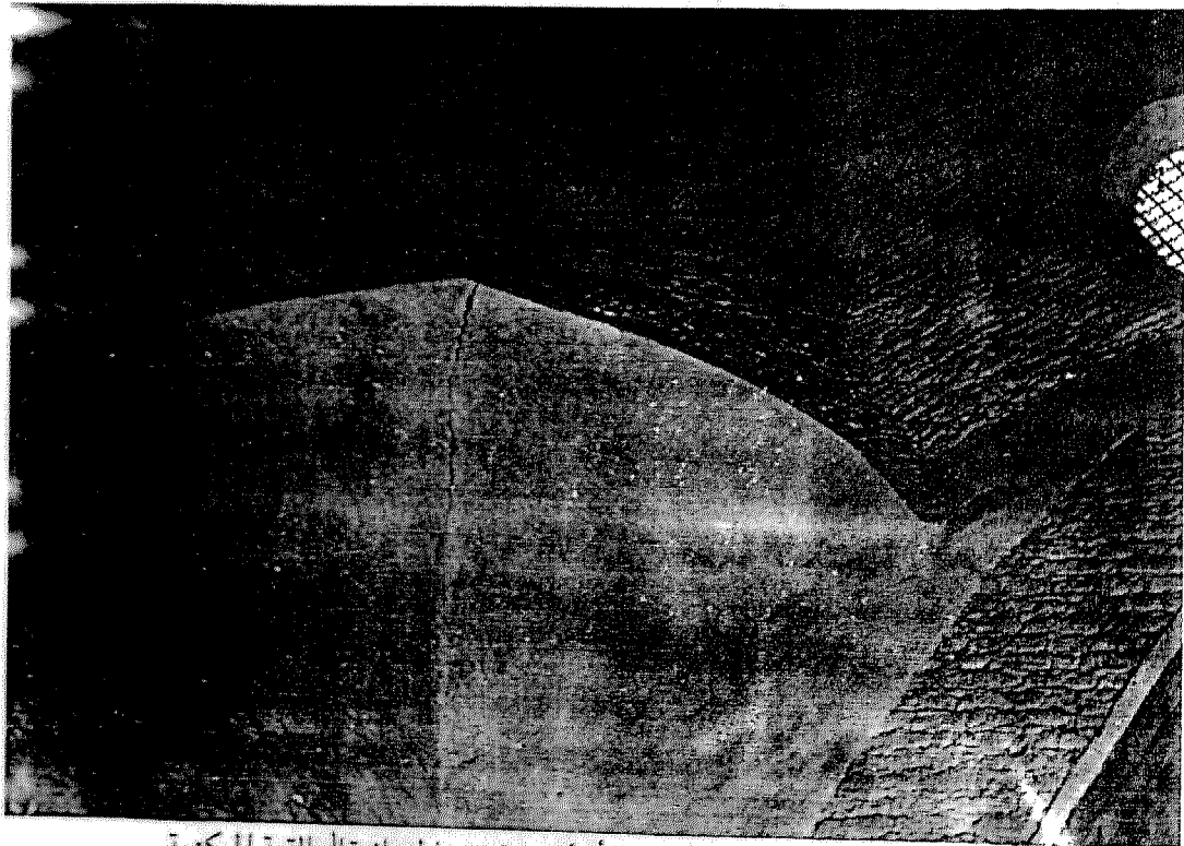
شكل (٧٩) حيس ، مدرسة الأسكندرية ، مناطق انتقال القبة المركزية
