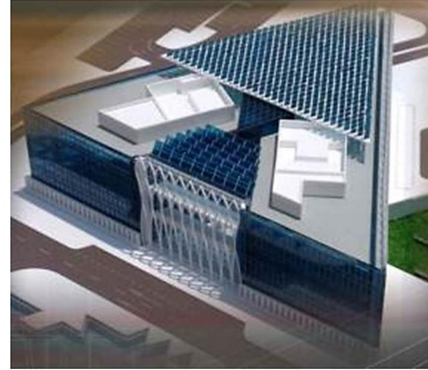
استخدام الخلايا الكهروضوئية فوق سطح المبنى
