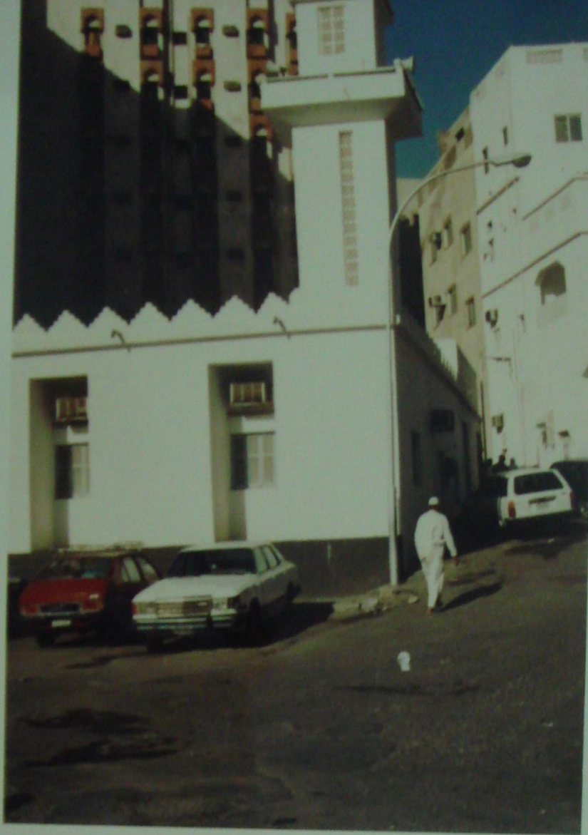
لوحة رقم ( ١ ) : مسجد الاجابة : الواجهة الشرقية ، وجزء من الواجهة الجنوبية ( القبلة ) .
