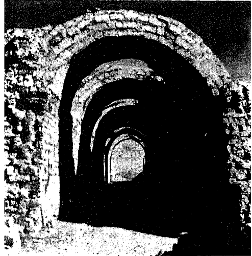
أحد المخازن بمعبد الرمسوم .. وتظهر موازيك الطوب فى الوضع الطولى والأفقى
