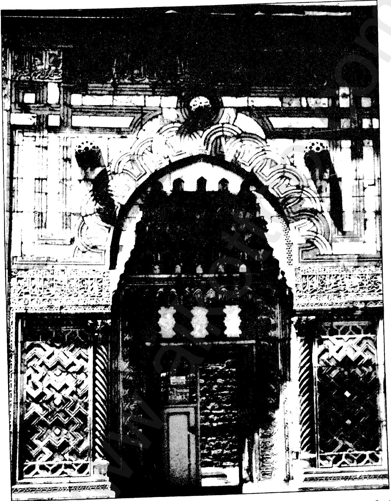
لوحة ٣٣٠- المدرسة القاراتائية الكبرى . البوابة الخارجية ، ويبدو فيها التأثر بالعمارة الشامية من حيث التكوين ومقياس الزخارف .
