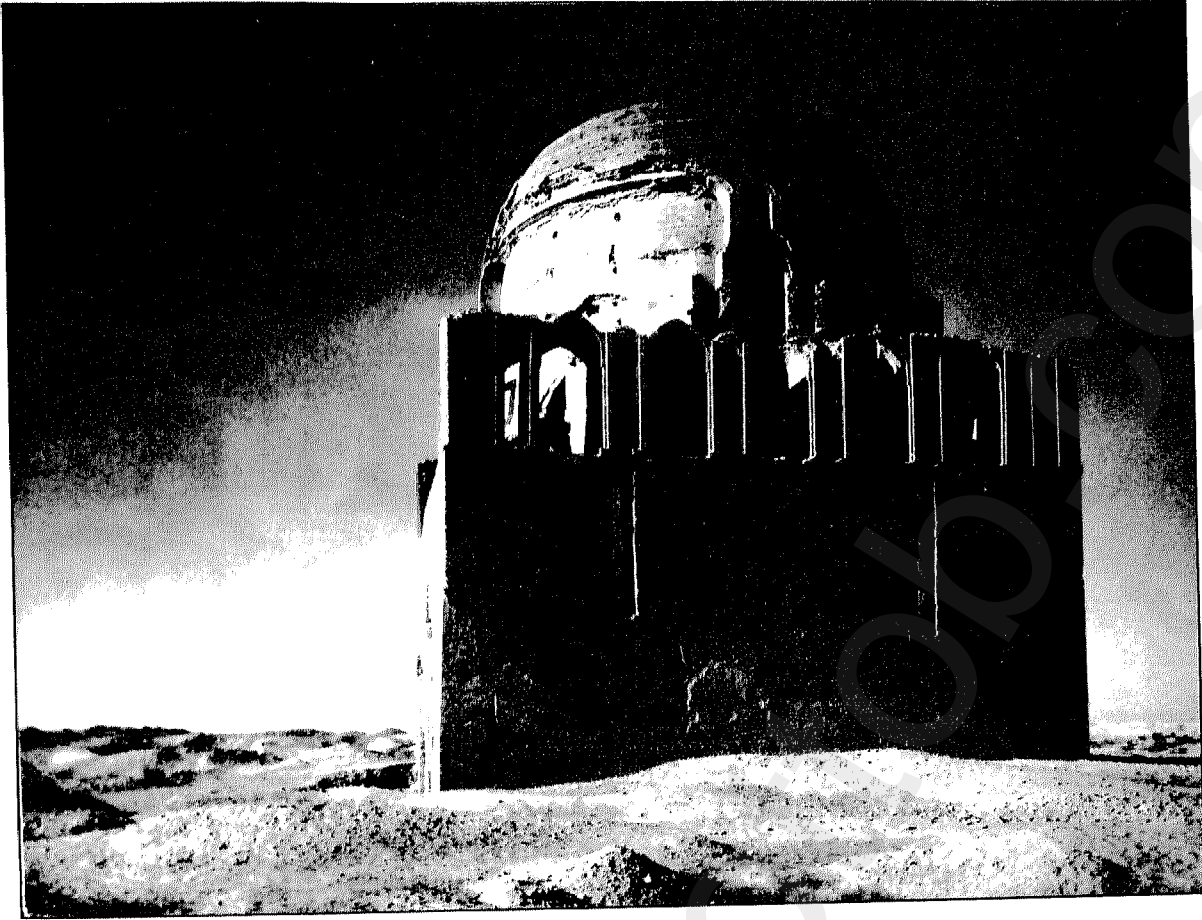
لوحة ٢٦٢ - الوجيهة الشرقية لضريح السلطان سنجر . وتلاحظ الربط بين القببة الكروية وصف العقود الذي يعلو الجدار بواسطة التنظيم المعماري بين هذه العقود وشباك القببة .
