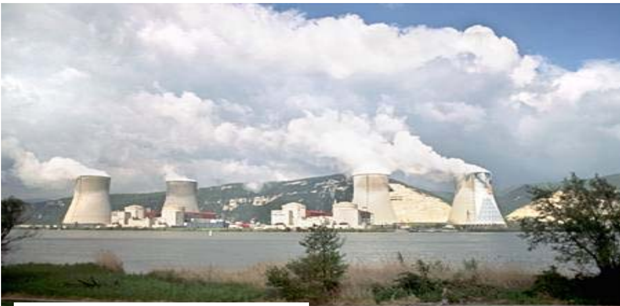
محطة نووية لإنتاج الطاقة الكهربائية
