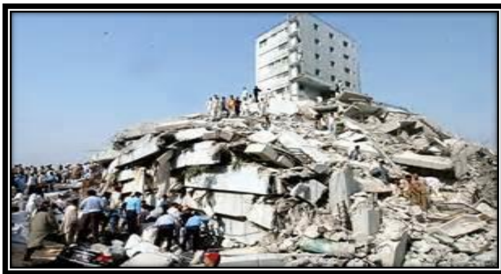
كسر في المباني بفعل زلازل
