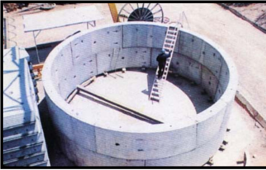
حلقات خرسانية ذات تجويف بقطر ٨,٣٥ متر (مترو أنفاق القاهرة)
