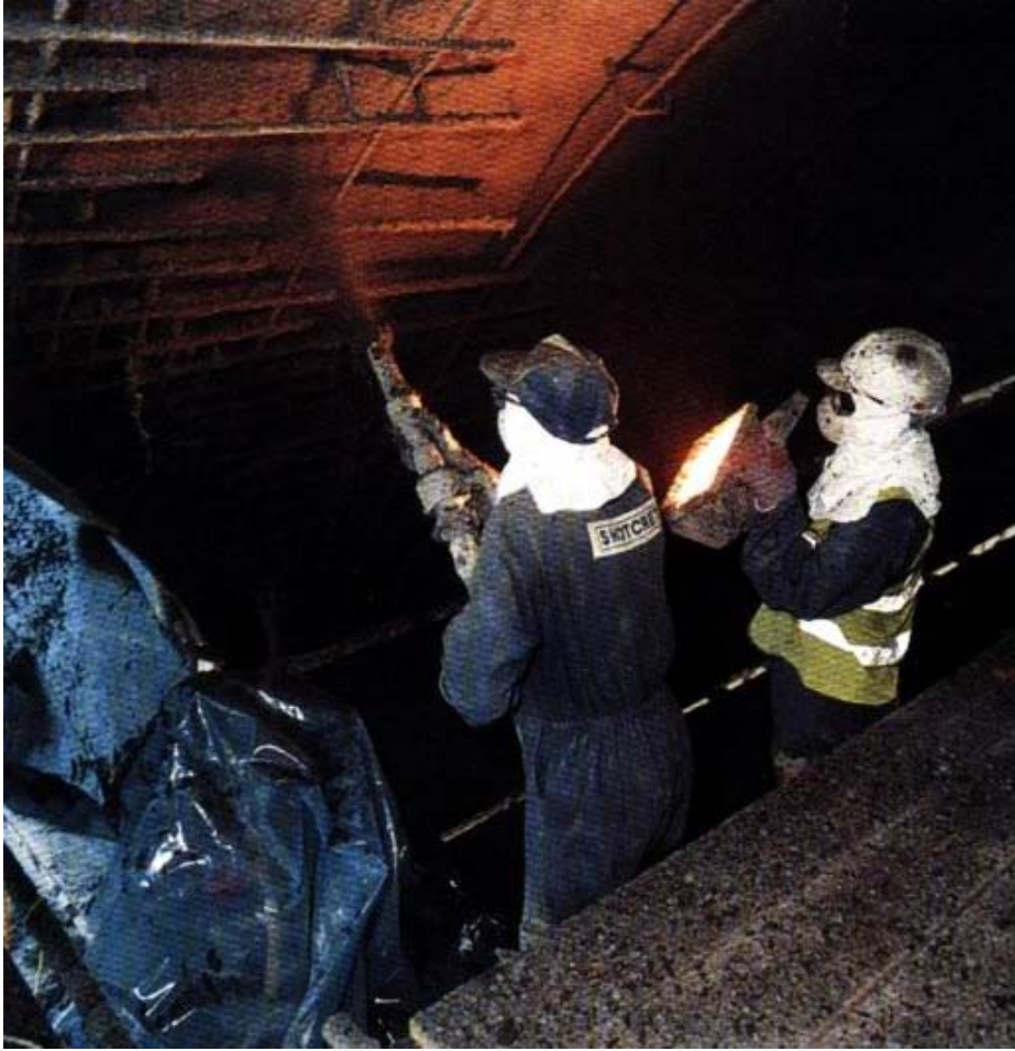
شكل (٣-٢٠) صورة توضح إستخدام الخرسانة المقذوفة في أحد الأنفاق.
