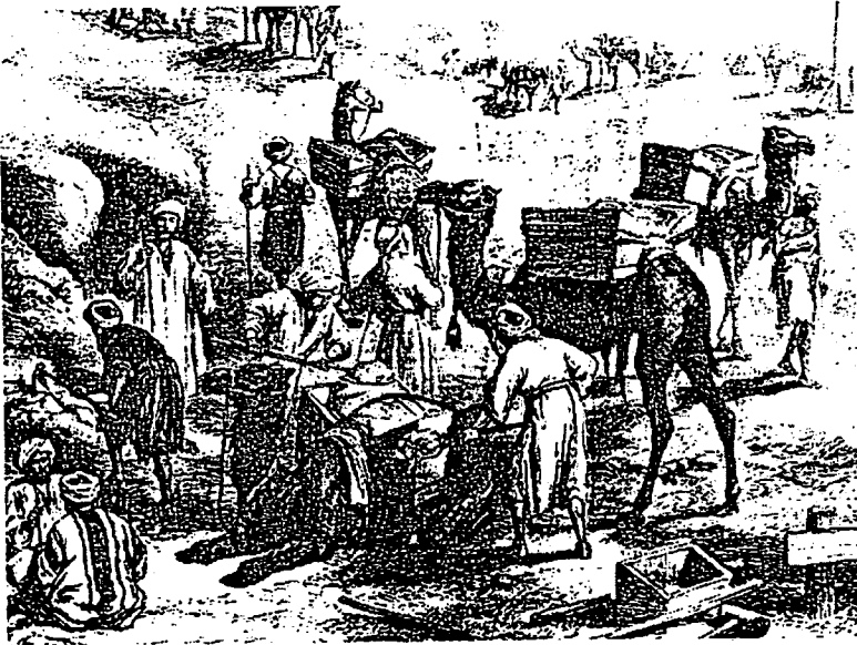
* أعمال الحفر فى قناة السويس
